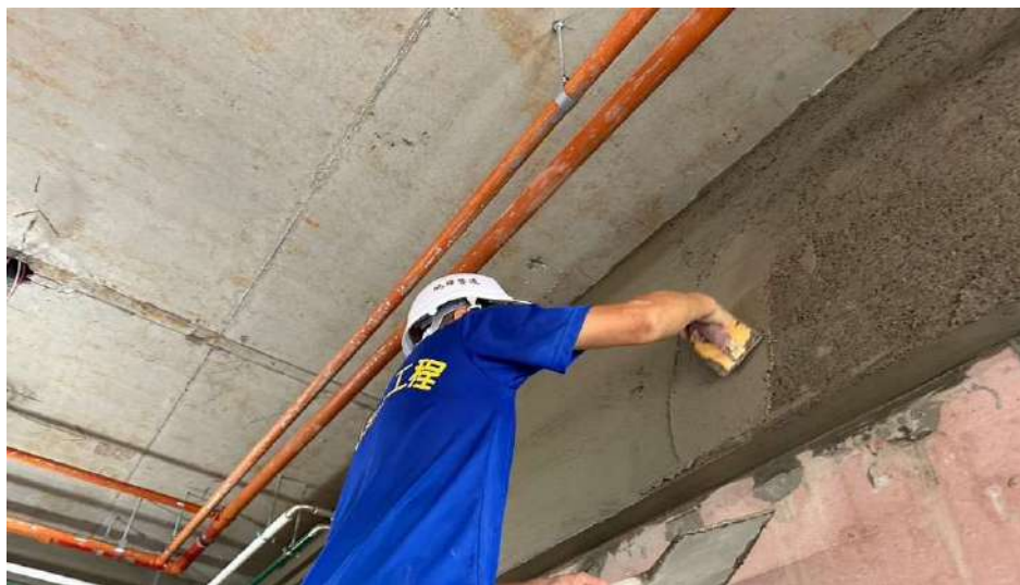
11F室內打底施作
