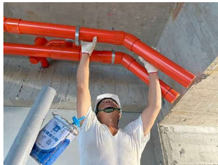
2F排水管吊管施作
