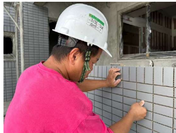
12F北向外牆磁磚施作
