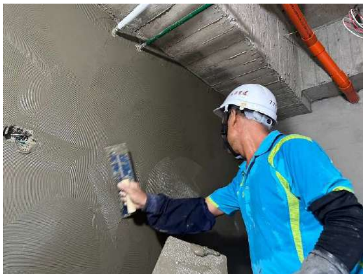
11F內牆粉光施作
