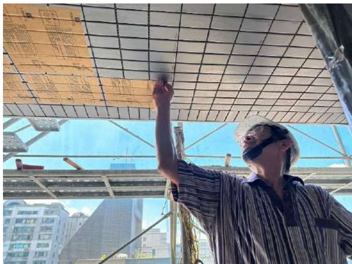
9F南向外牆磁磚施作
