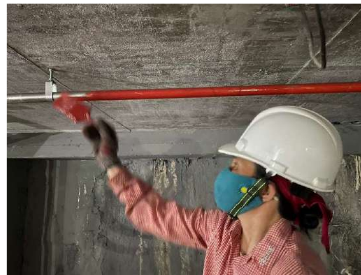
B2F消防油漆施作
