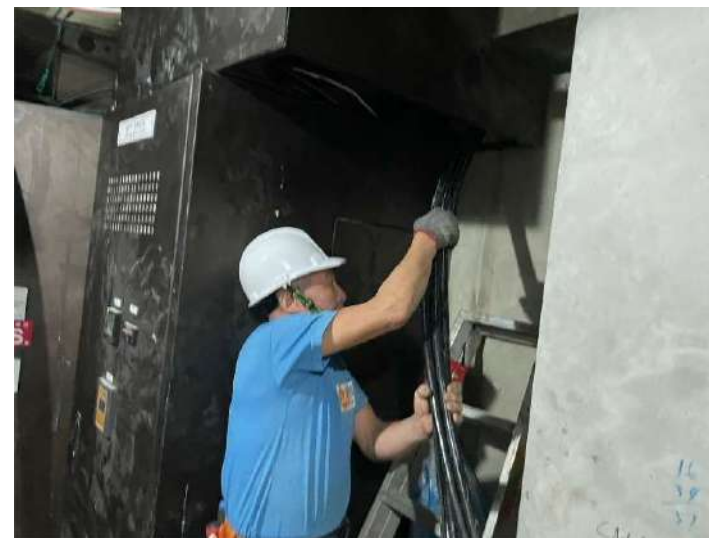
B1F盤體電纜線拉線
