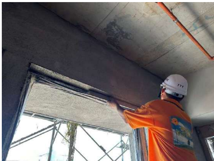
12F室內打底施作
