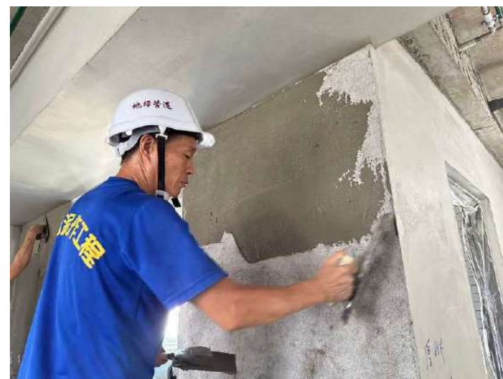
12F內牆粉光施作
