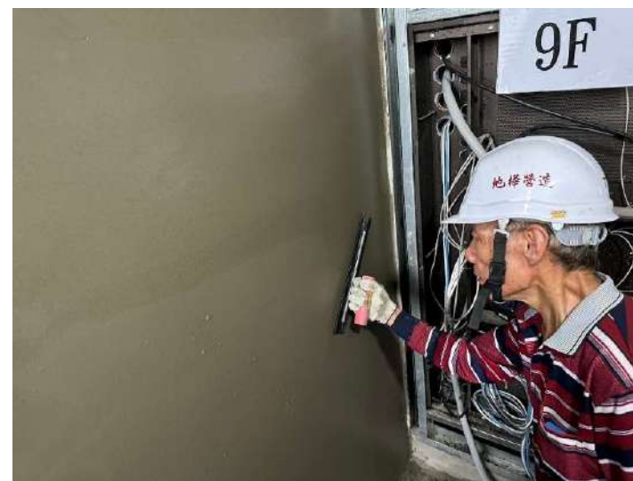
9F內牆粉光施作
