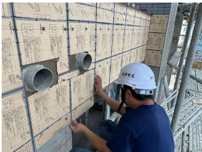
7F南側外牆磁磚施作
