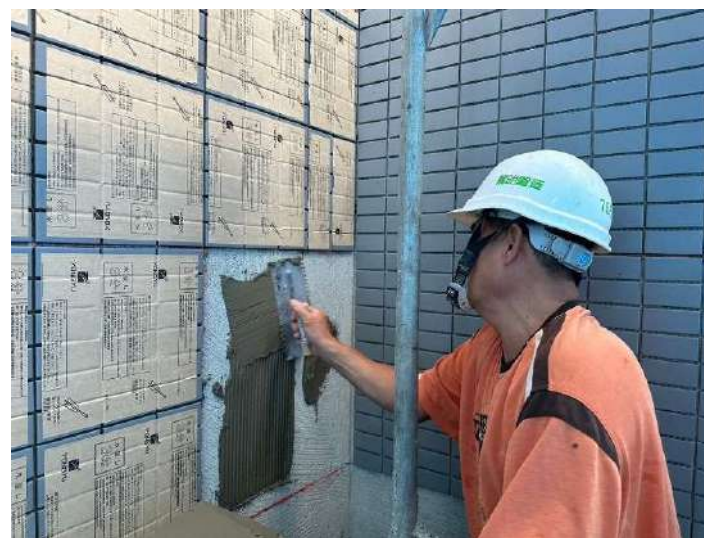
5F北向外牆磁磚施作
