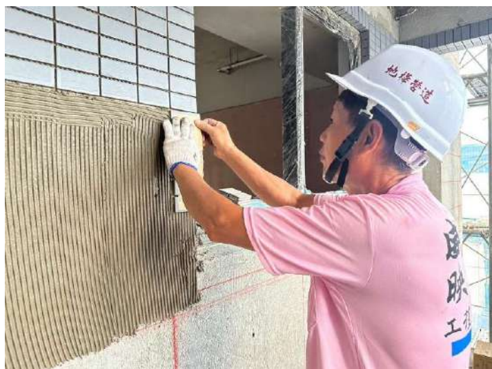
10F北向外牆磁磚施作
