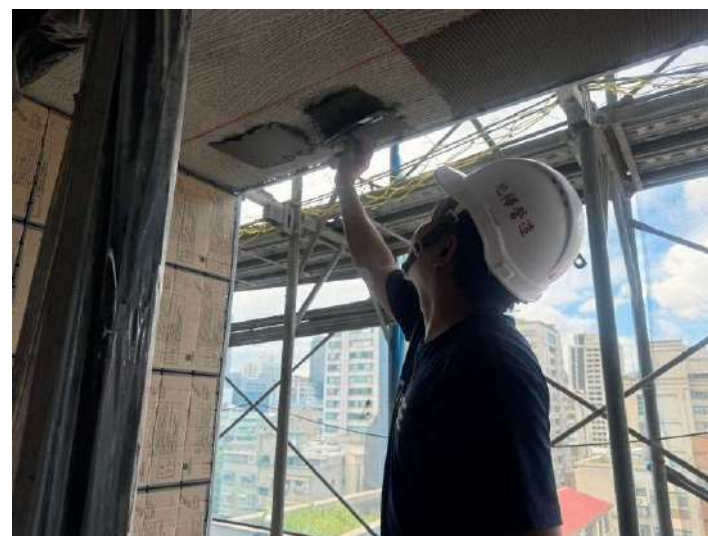
9F北向外牆磁磚施作
