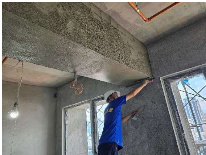
12F室內打底施作
