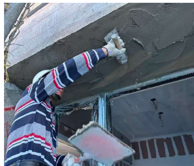
4F外牆打底施作
