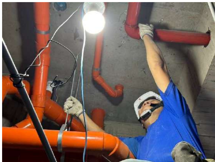
1F排水管施作
