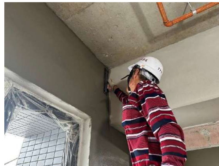
11F內牆粉光施作
