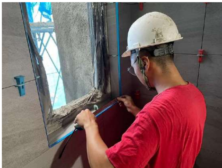
6F浴廁磁磚施作
