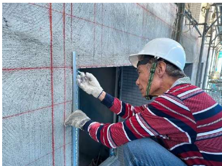
外牆收邊條施作
