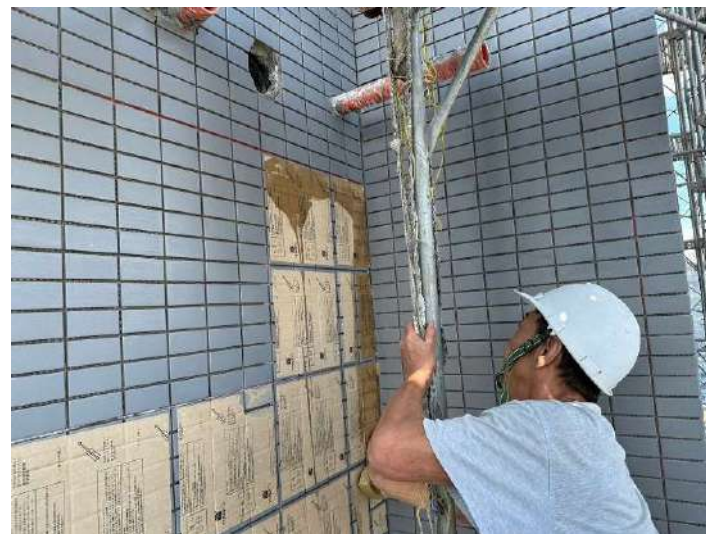
9F北向外牆磁磚施作
