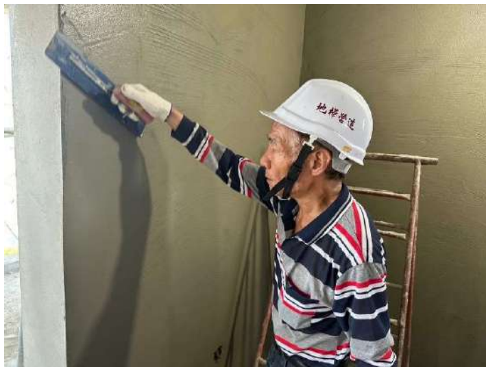
12F內牆粉光施作
