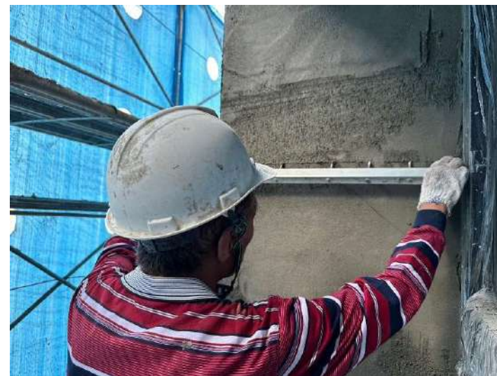
4F外牆打底施作
