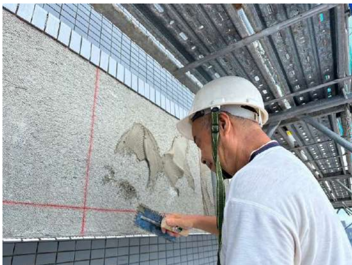
R1外牆磁磚施作
