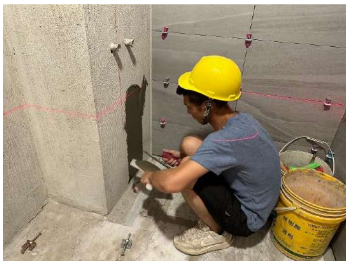
5F浴廁磁磚施作
