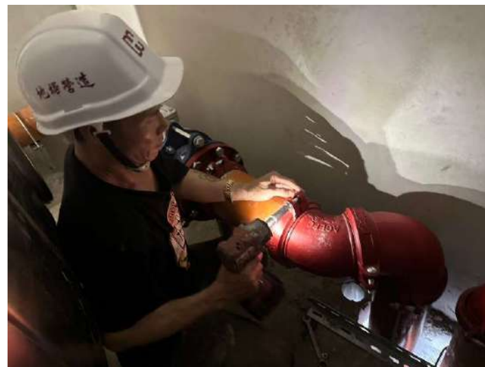
B1F-B2F消防管施作
