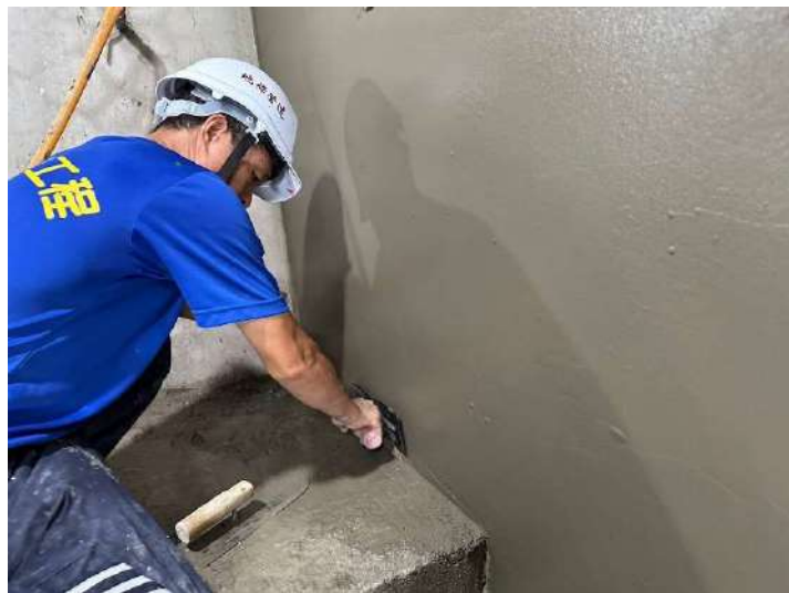
9F內牆粉光施作
