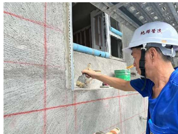
外牆滴水條施作
