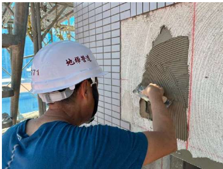
6F北向側外牆磁磚施作
