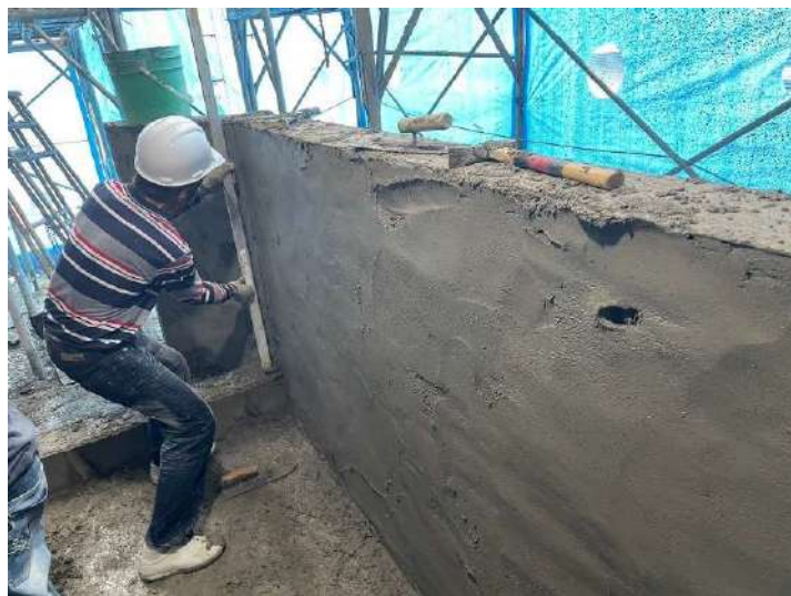
4F外牆打底施作
