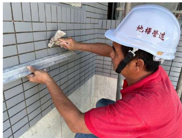
6F北向外牆磁磚施作
