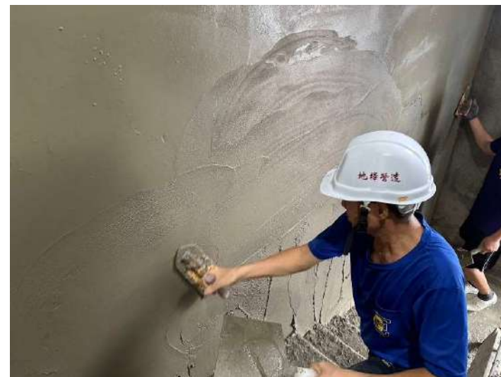
10F內牆粉光施作
