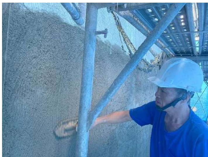
4F外牆打底施作
