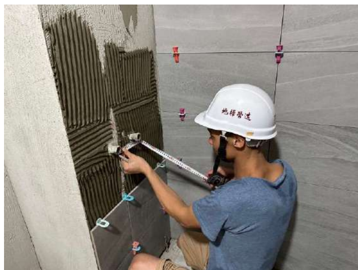
7F浴廁磁磚施作
