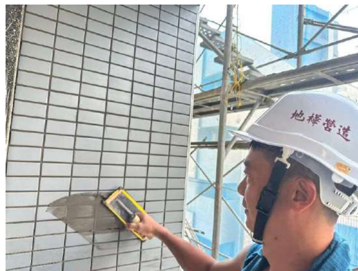
南向外牆磁磚填縫施作
