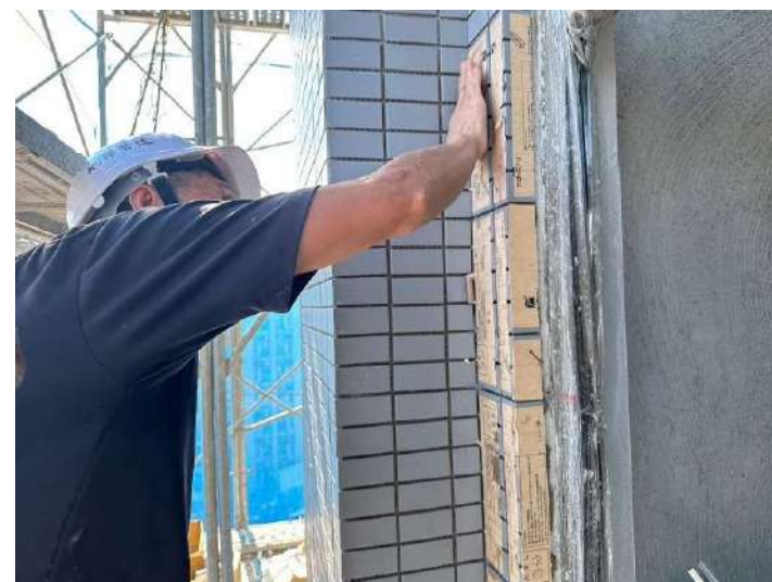
12F北向外牆磁磚施作
