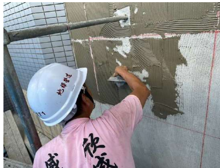
5F北向外牆磁磚施作
