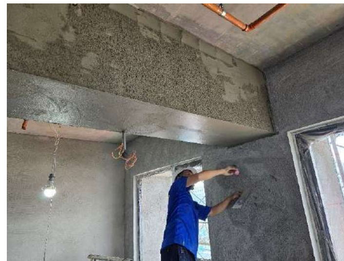
12F室內打底施作
