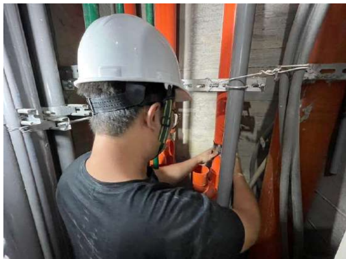
2F排水管施作
