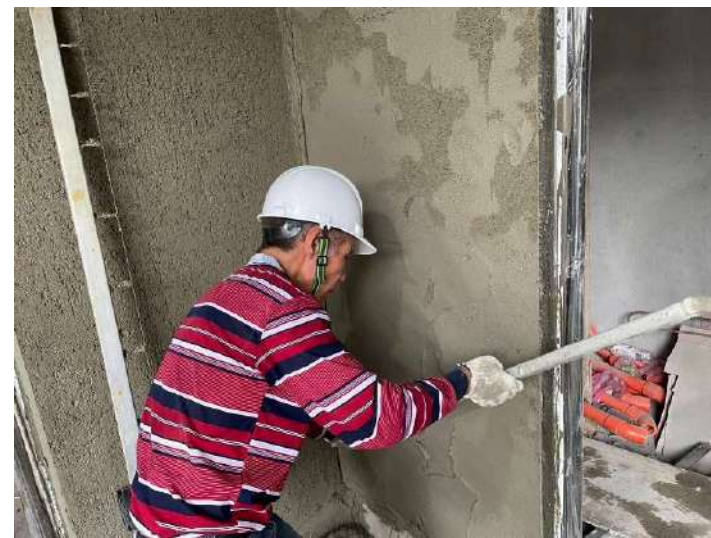
3F外牆打底施作
