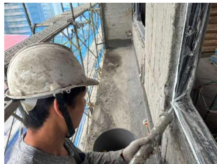
鋁窗防水PU填縫施作
