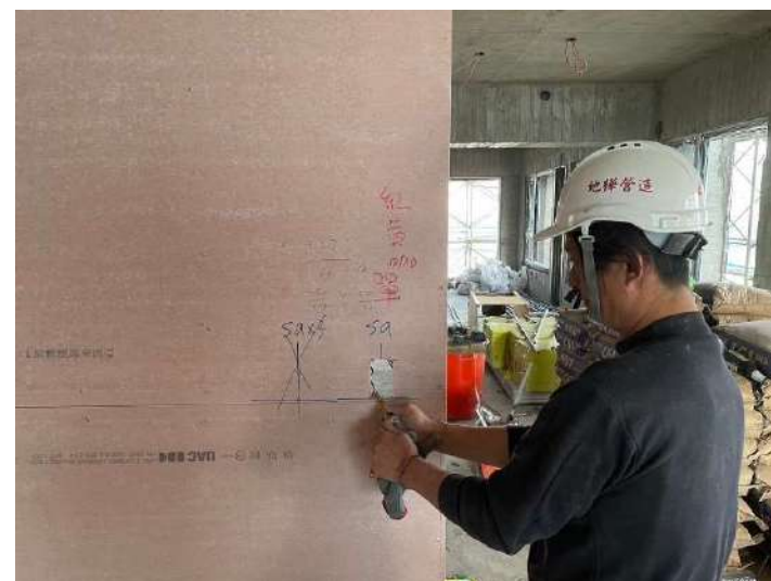
10F輕隔間電管拉線施作
