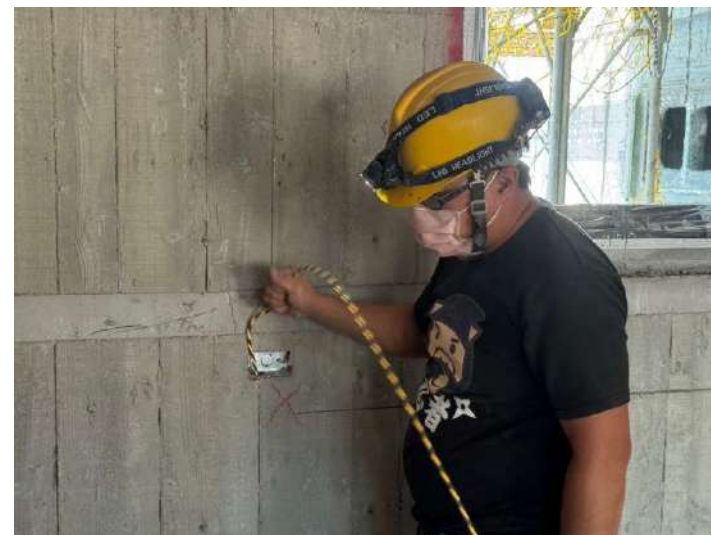
12F室內清管拉線
