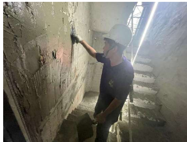
6F牆面打底施作
