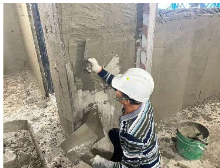
4F牆面打底施作
