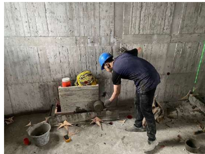
12F輕隔間止水墩施作
