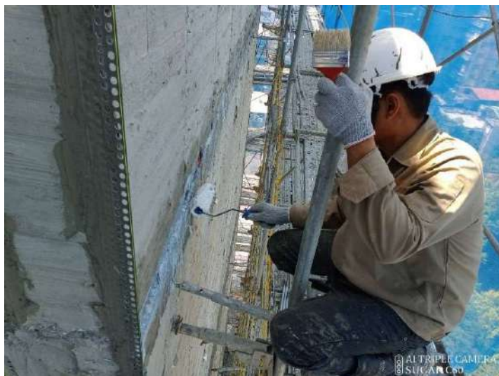
RF層縫防水底漆施作
