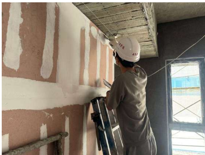
2F輕隔間批土施作
