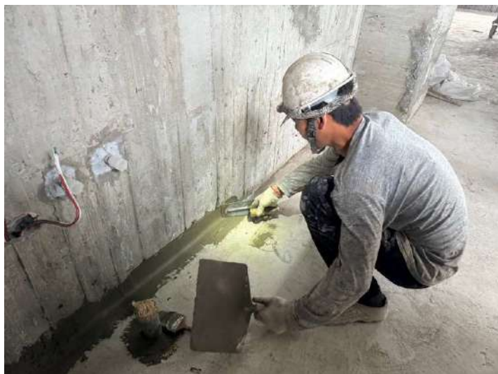
廚房防水倒角施作
