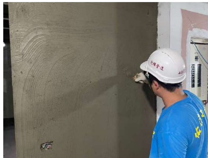
4F牆面打底施作
