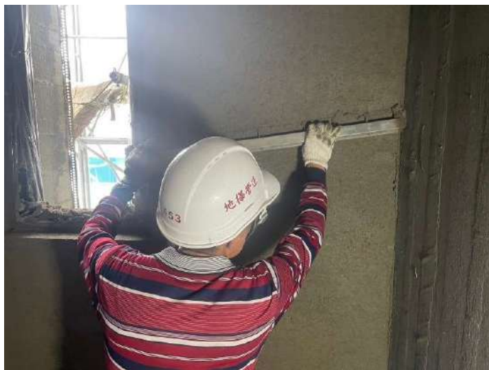
5F牆面打底施作
