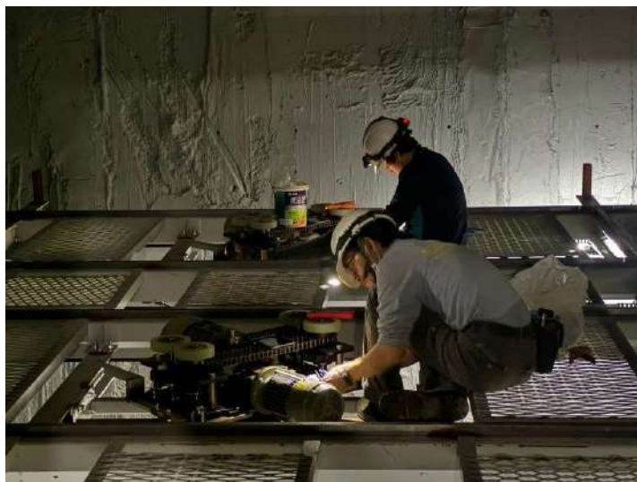
停車設備電路結線
