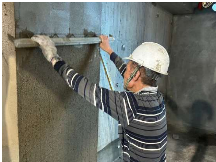
4F牆面打底施作
