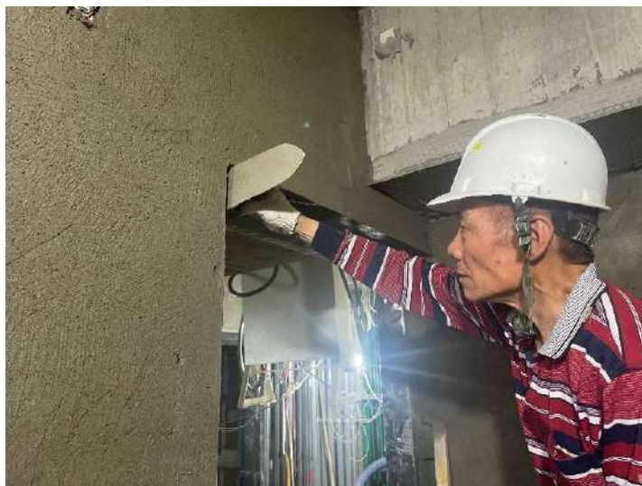
6F牆面打底施作
