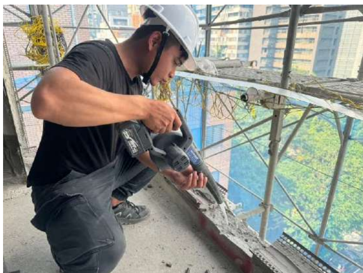
欄杆基座化錨螺栓施作
