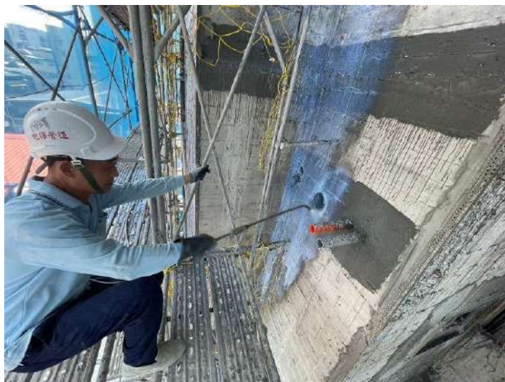
外牆打底前噴灑新舊水泥接著劑
