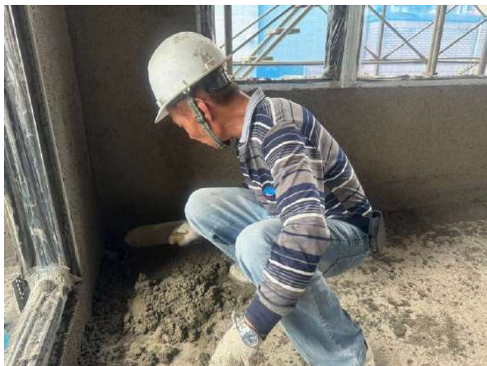
6F牆面打底施作
