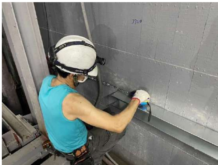
停車設備線槽施作
