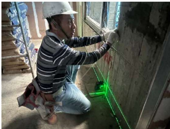
4F室內牆面泥作放樣
