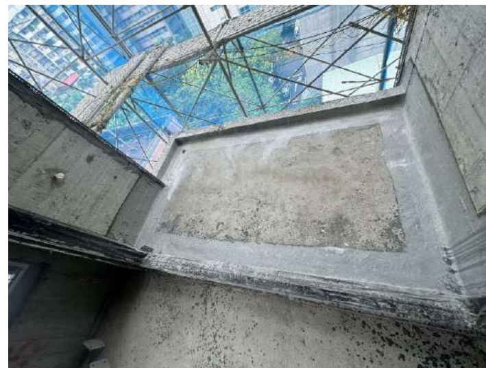
陽台防水倒角施作
