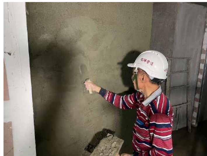
5F牆面打底施作
