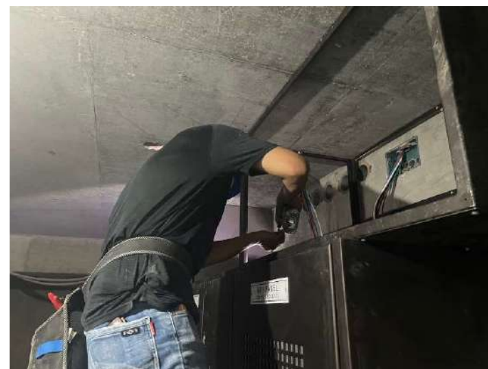
B2F緊急電源總盤拉線
