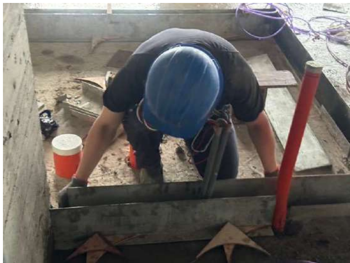
10F輕隔間止水墩施作
