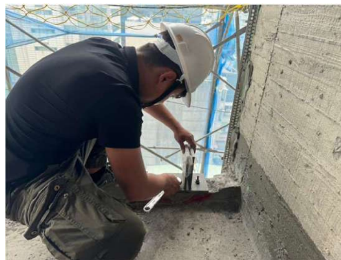
欄杆基座安裝
