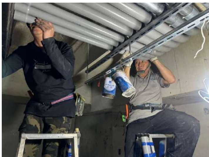
B2F幹管電路配置
