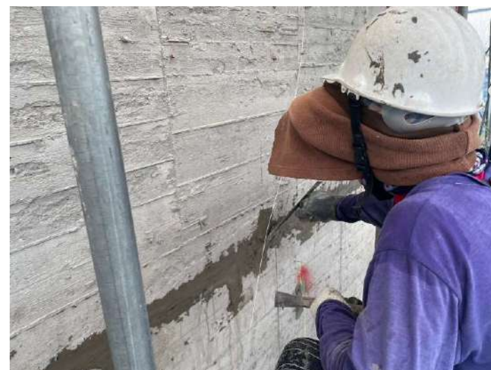
RF層縫樹脂砂漿施作
