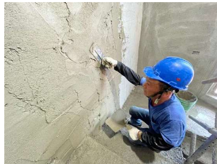
7F室內樓梯牆面打底
