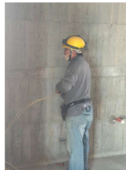
室內拉線施作
