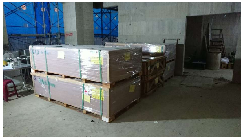
2F-8F 輕隔間材料進場
