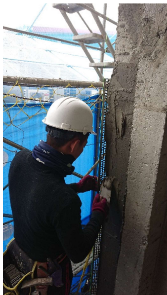
3F-8F 外牆泥作吊線
