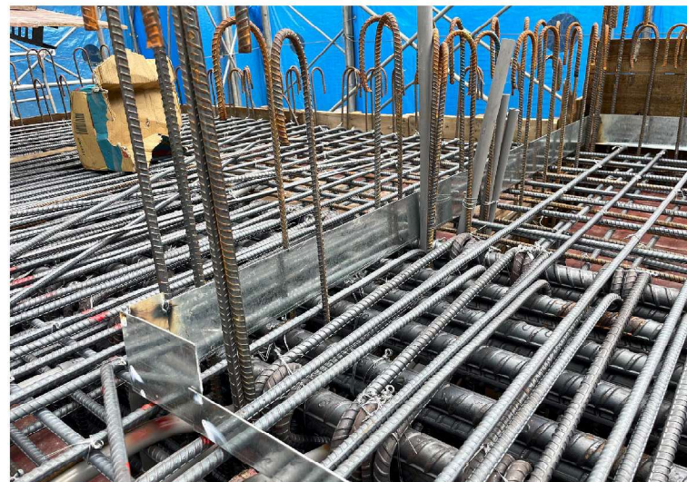
廁所範圍施作止水角鋼
