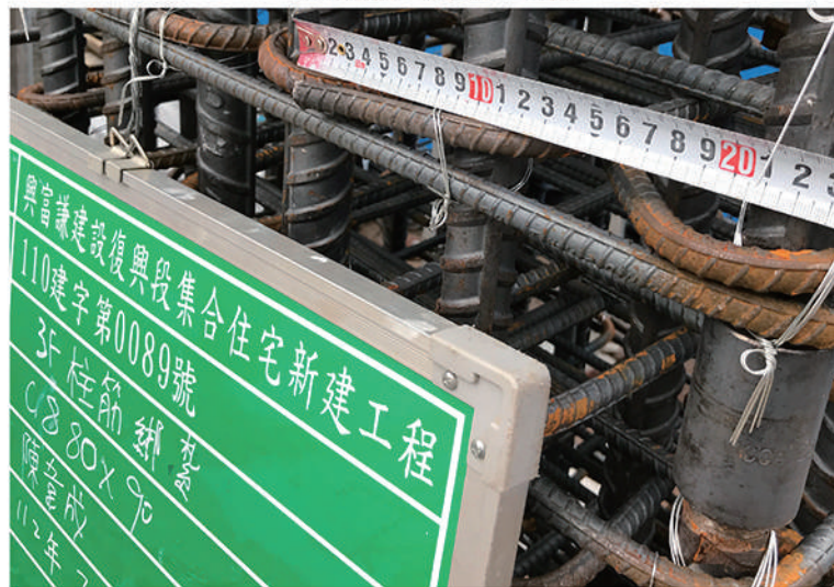
柱筋彎鉤查驗
