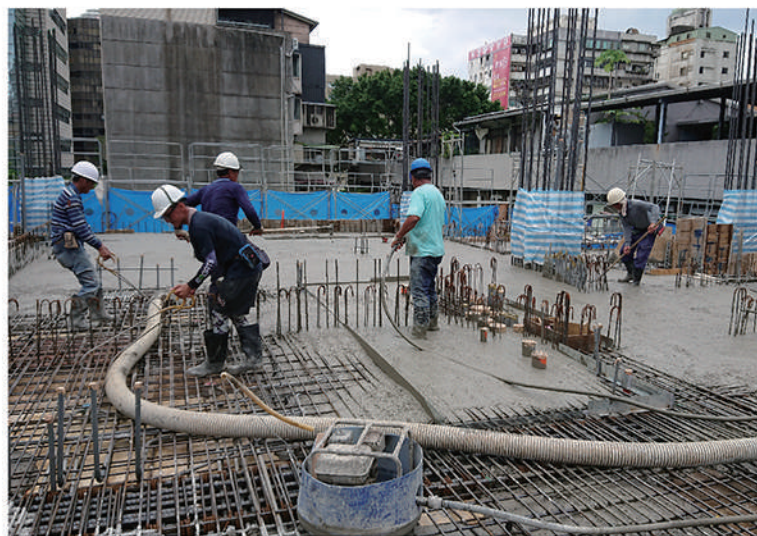
4FL混凝土澆置
