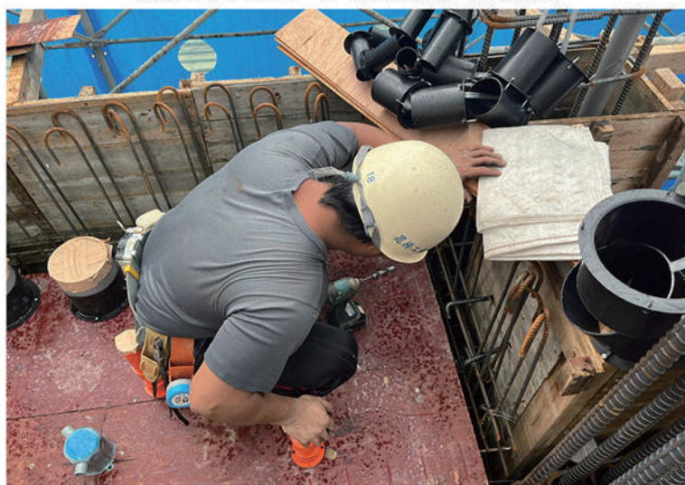
鷹架工程三角架預埋螺絲
