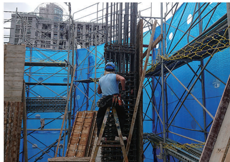
機電配管電盒安裝
