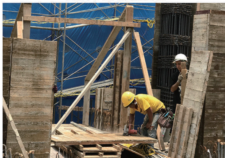
柱牆單面模板組立
