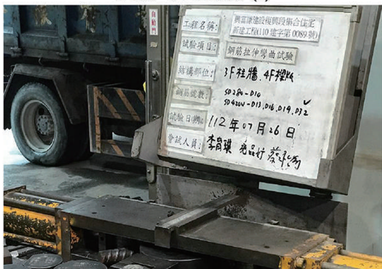
鋼筋彎曲試驗 (1)
