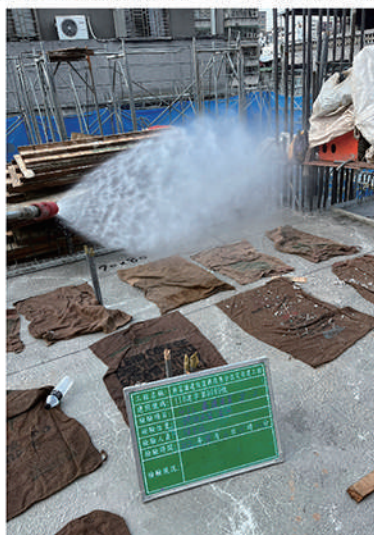
灌漿後鋪設麻布袋灑水養護
