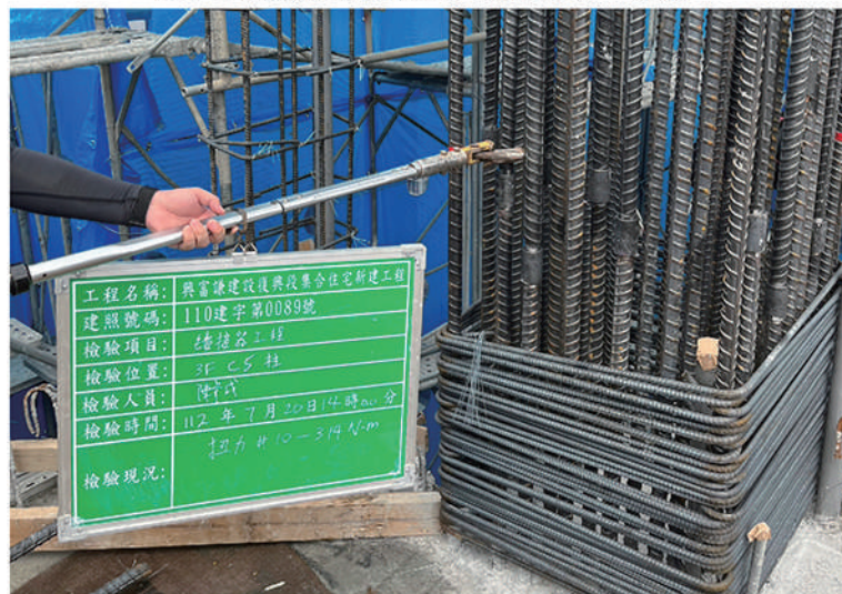
3F柱筋續接扭力測試查驗
