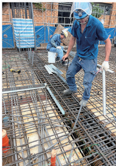
止水鋼板施作
