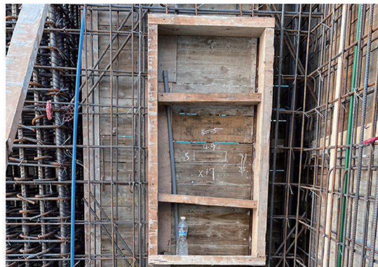
牆筋開口補強
