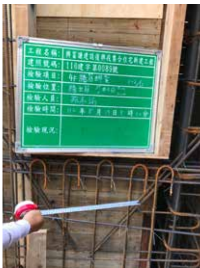
牆筋開口補強
