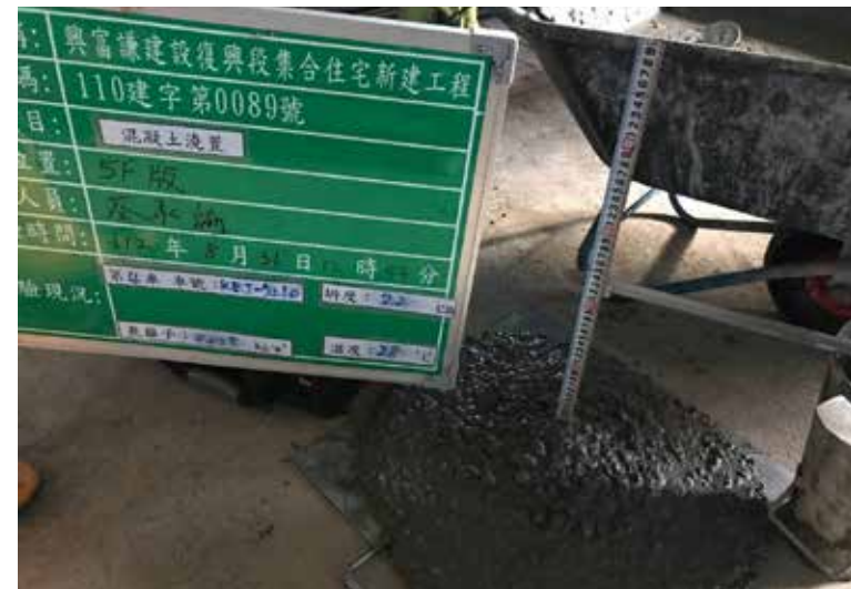
混凝土坍度檢測
