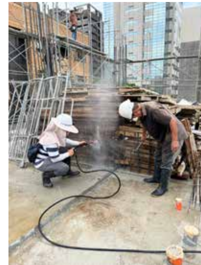
鋼筋混凝土渣高壓清洗
