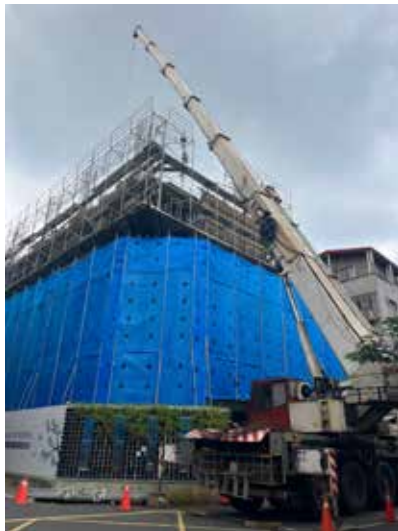
樑版鋼筋吊料
