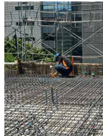
廁所止水鋼板施作
