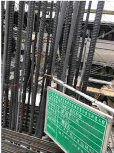
4F柱筋續接扭力測試查驗
