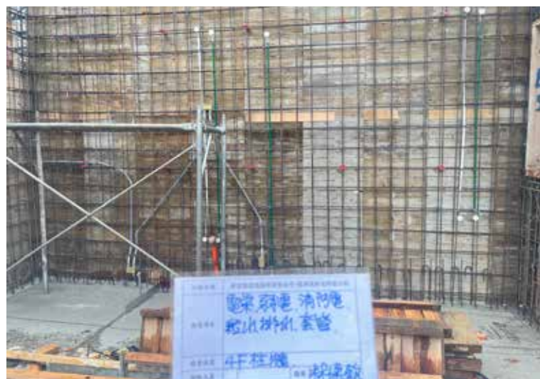
柱牆配管查驗
