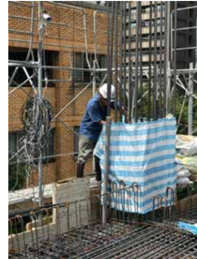
柱頭鋪設帆布保護，避免灌漿污染
