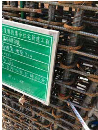
柱筋彎鉤查驗
