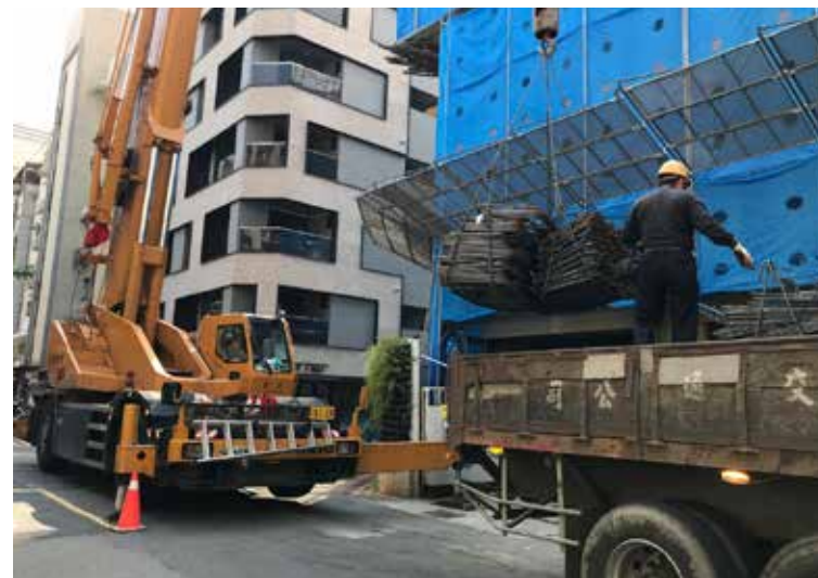
樑版鋼筋吊料
