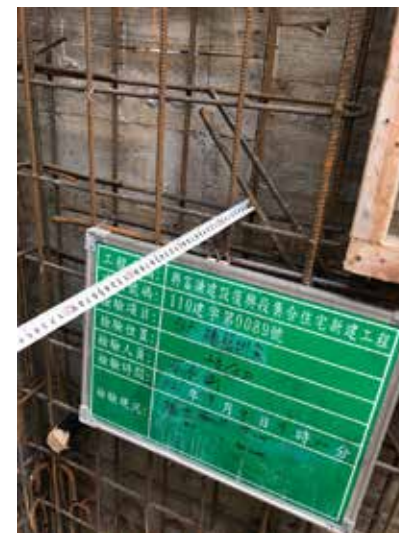
牆筋開口補強
