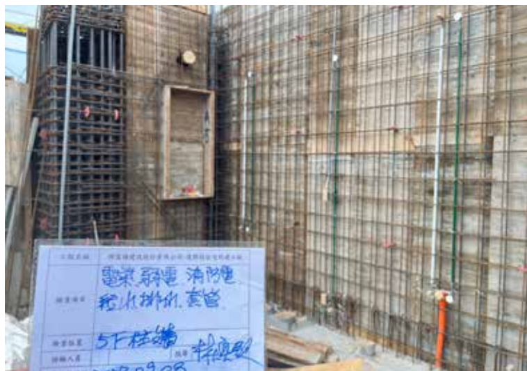
柱牆配管查驗
