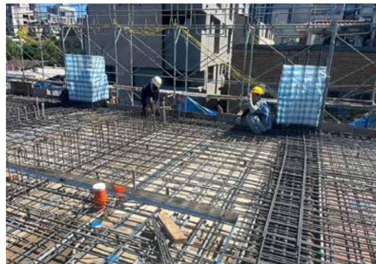
廁所止水鋼板施作
