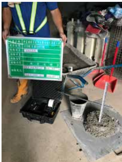
混凝土坍度檢測
