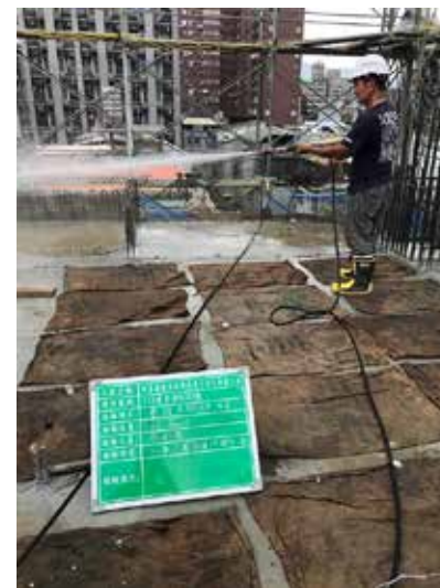
灌漿後鋪設麻布袋灑水養護
