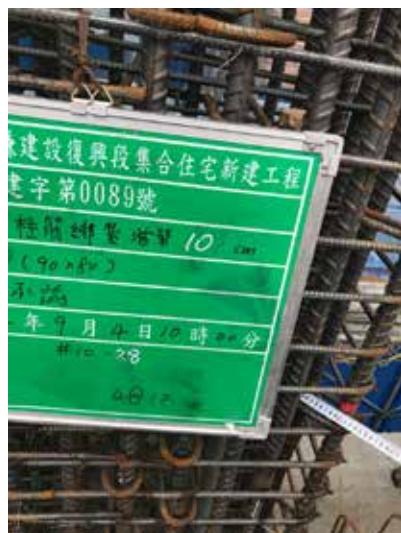
柱筋彎鉤查驗
