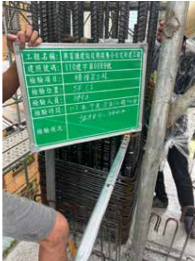
5F柱筋續接扭力測試查驗
