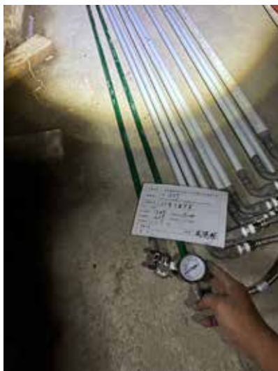
給水管配管前壓力測試
