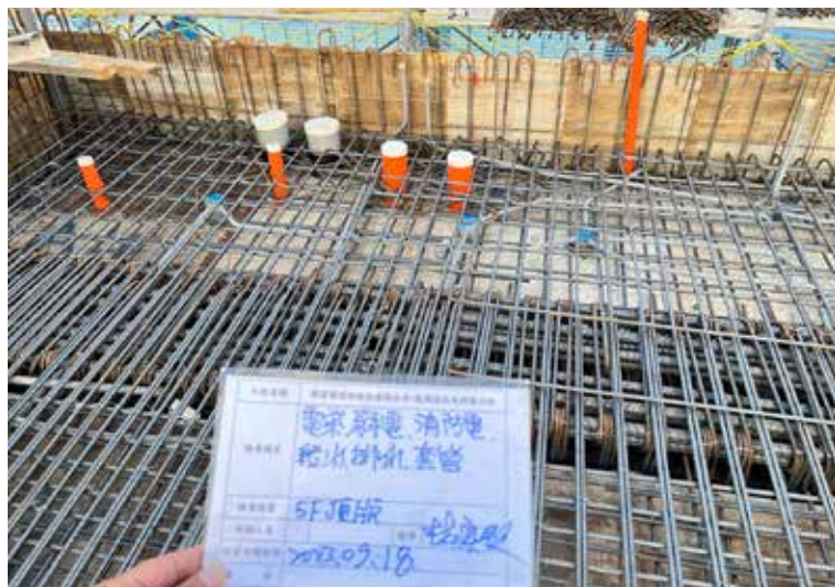
機電配管查驗
