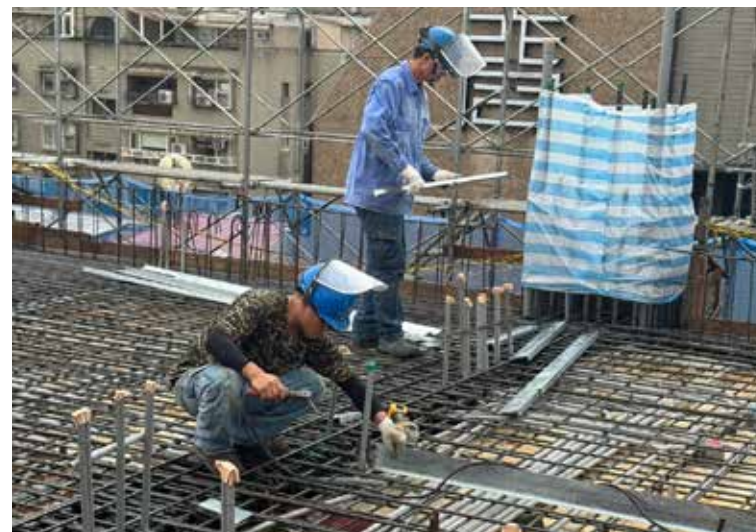
止水鋼板施作
