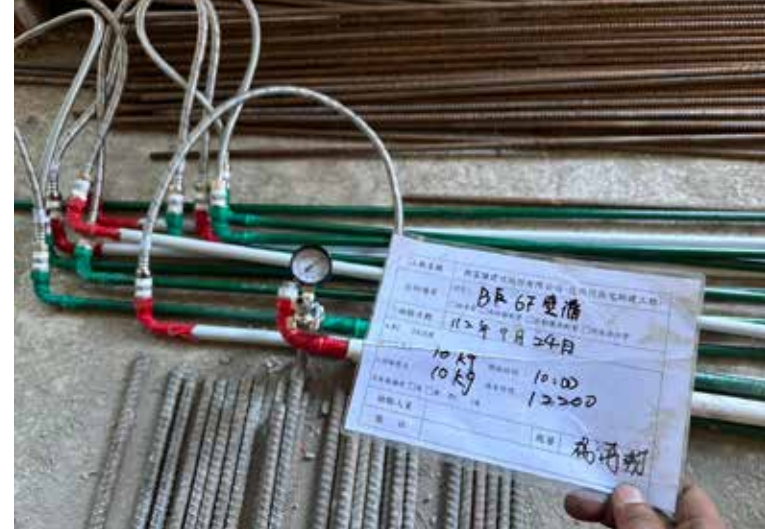
給水管配管前壓力測試
