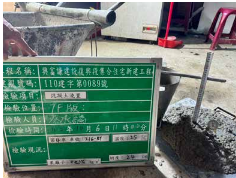
混凝土坍度檢測
