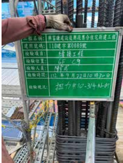
6F柱筋續接扭力測試查驗
