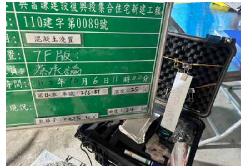
混凝土氯離子檢測
