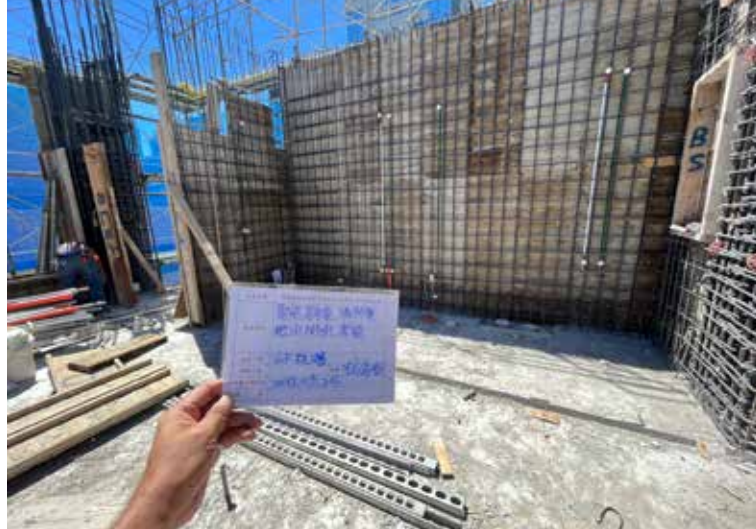
柱牆配管查驗
