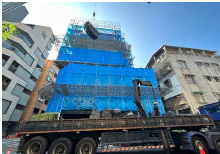
樑版鋼筋吊料
