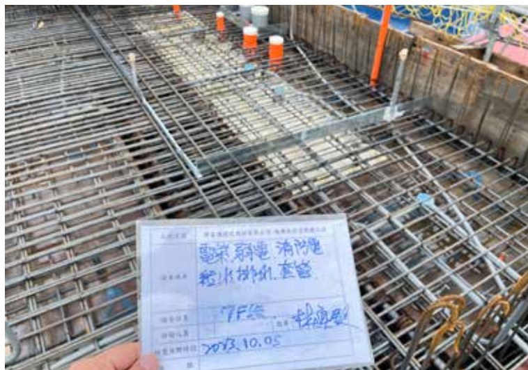
機電配管查驗
