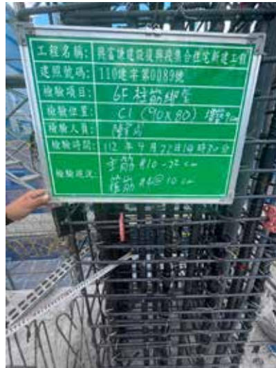
柱筋彎鉤查驗
