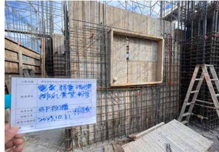
柱牆配管查驗
