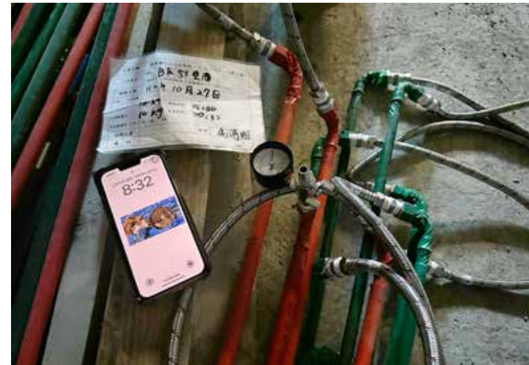
給水管配管前壓力測試(2)
