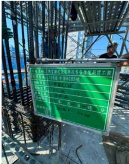
8F柱筋續接扭力測試查驗
