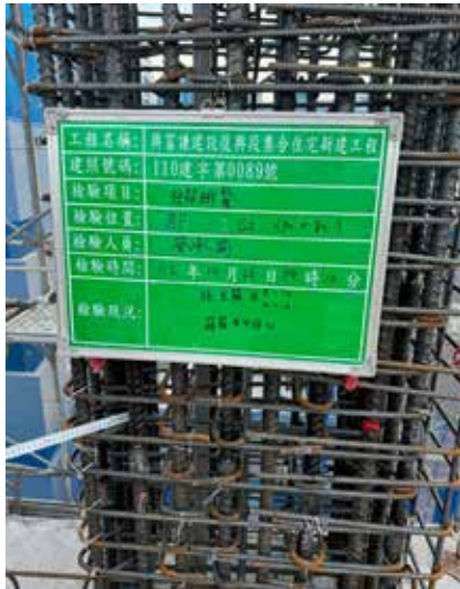
柱筋彎鉤查驗
