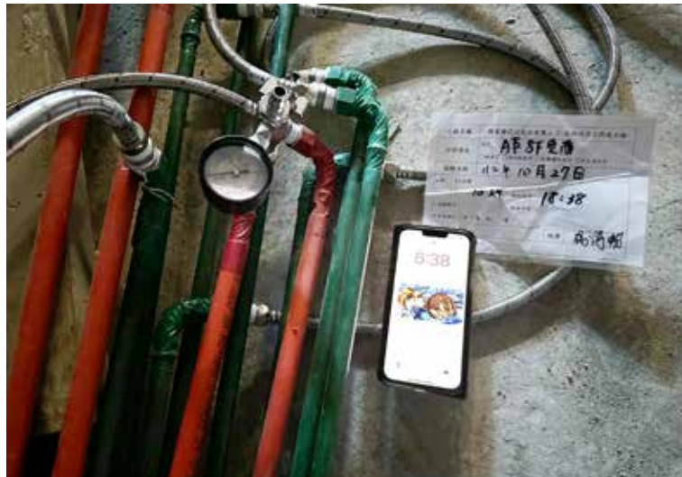
給水管配管前壓力測試(1)
