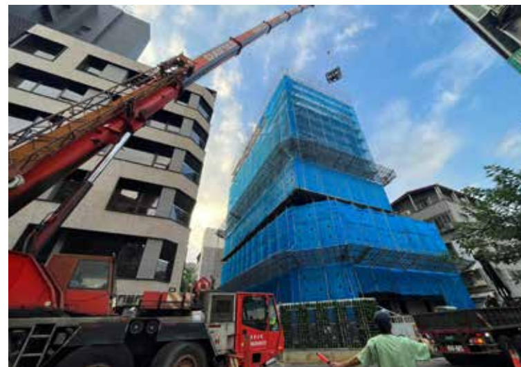
柱牆筋吊料
