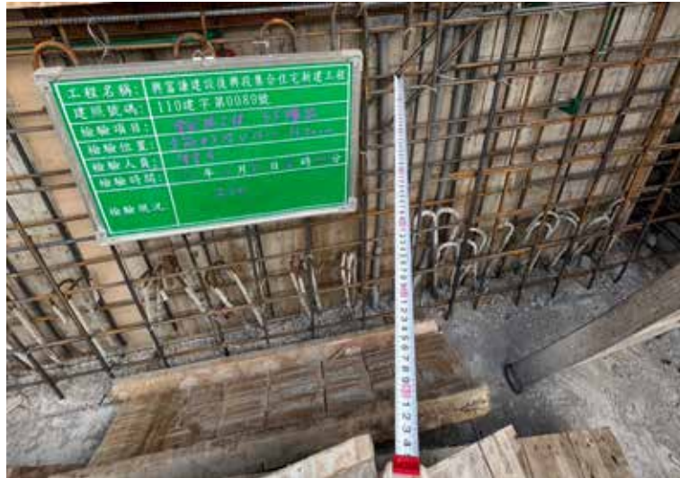
牆開口補強鋼筋
