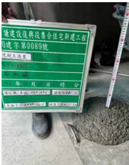
混凝土坍度檢測
