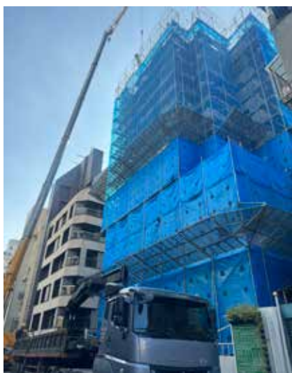
樑版鋼筋吊料
