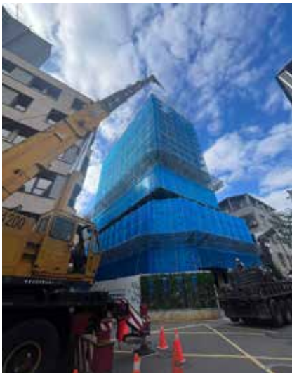
樑版鋼筋吊料
