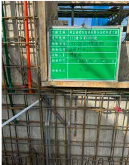
牆開口補強鋼筋
