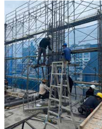
鋼筋柱筋綁紮
