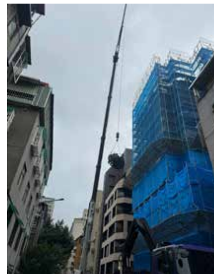
柱牆筋吊料
