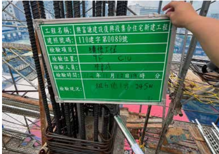
9F柱筋續接扭力測試查驗
