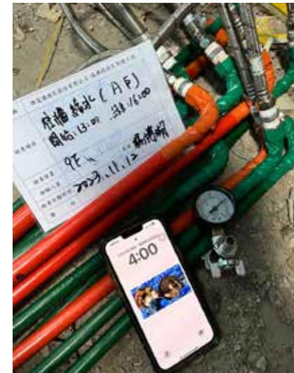
給水管配管前壓力測試
