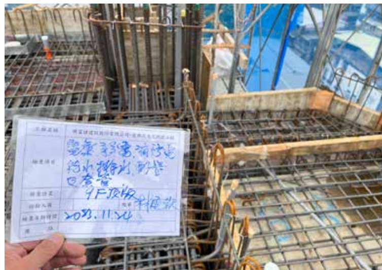
機電配管查驗
