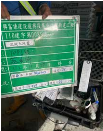
混凝土氯離子檢測
