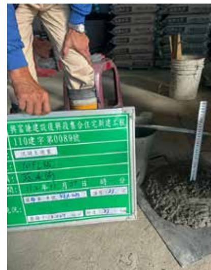
混凝土坍度檢測
