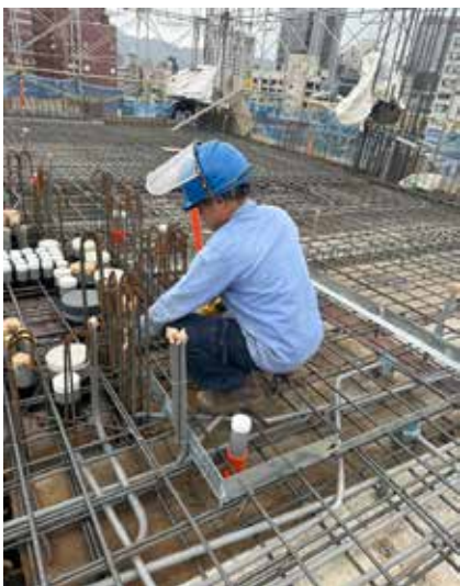
止水鋼板施作
