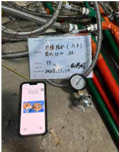
給水管配管前壓力測試
