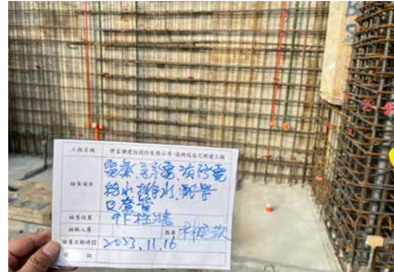
柱牆配管查驗
