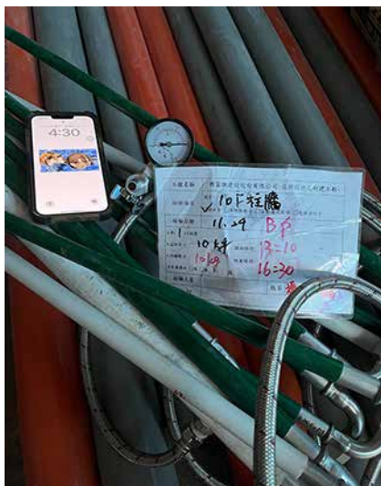
給水管配管前壓力測試
