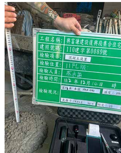
混凝土氯離子檢測
