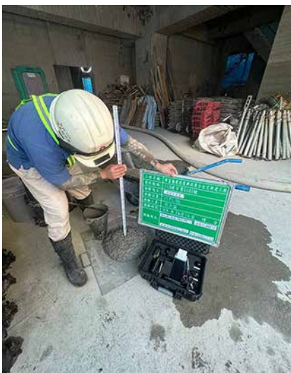
混凝土坍度檢測
