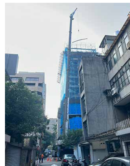
樑版鋼筋吊料
