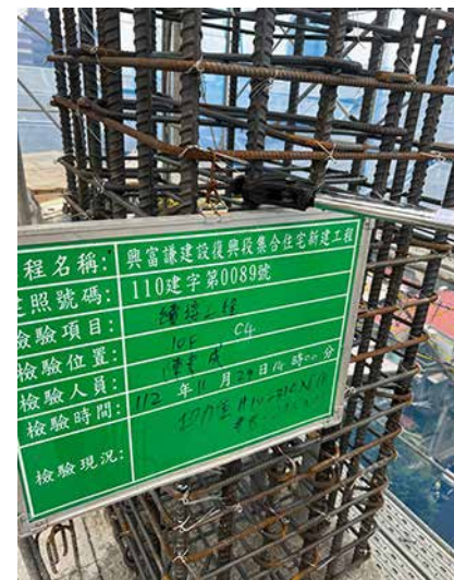
10F柱筋續接扭力測試查驗
