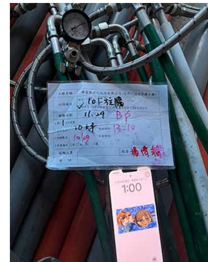
給水管配管前壓力測試
