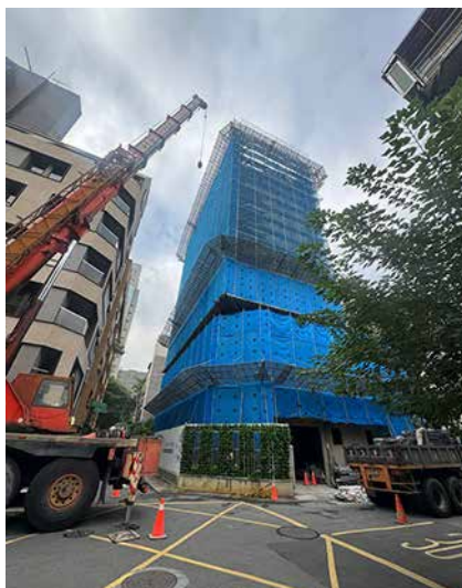
柱牆筋吊料
