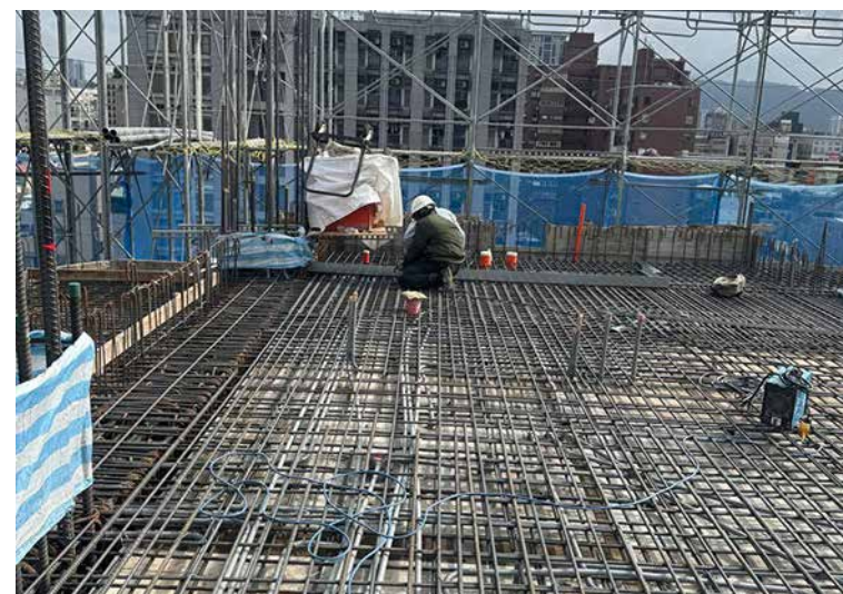
止水鋼板施作
