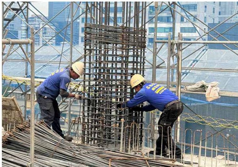
鋼筋柱筋綁紮
