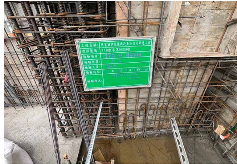
牆開口補強鋼筋
