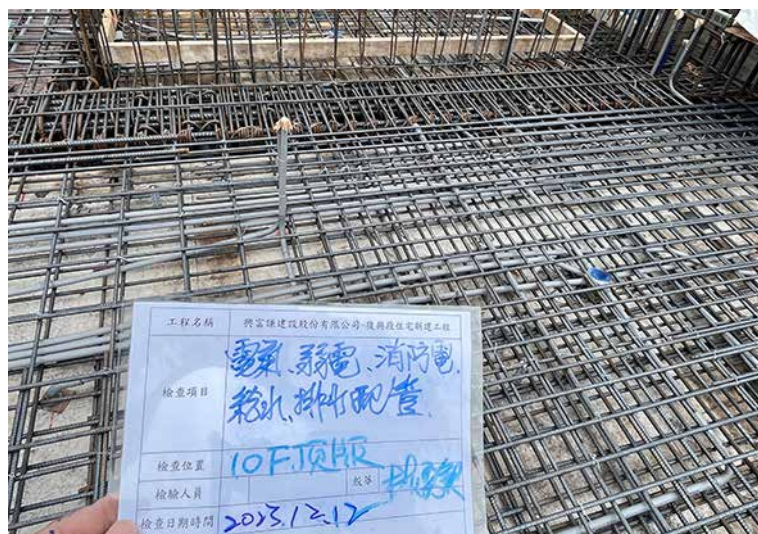
機電配管查驗
