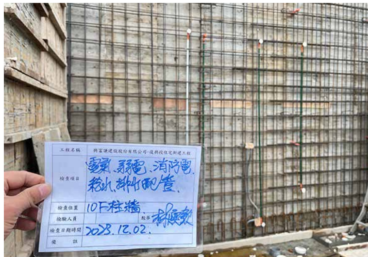
柱牆配管查驗
