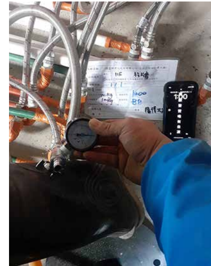
給水管配管前壓力測試
