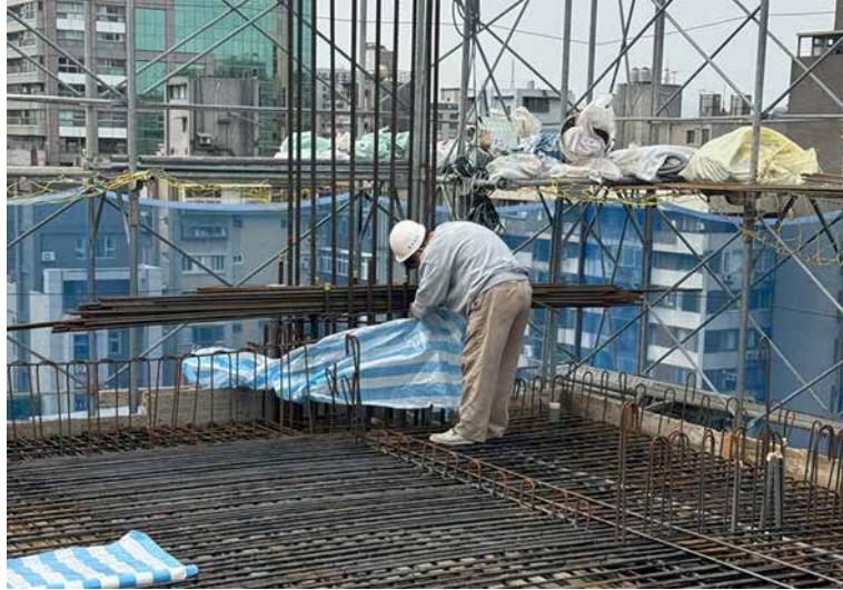
柱頭鋪設帆布保護，避免灌漿污染
