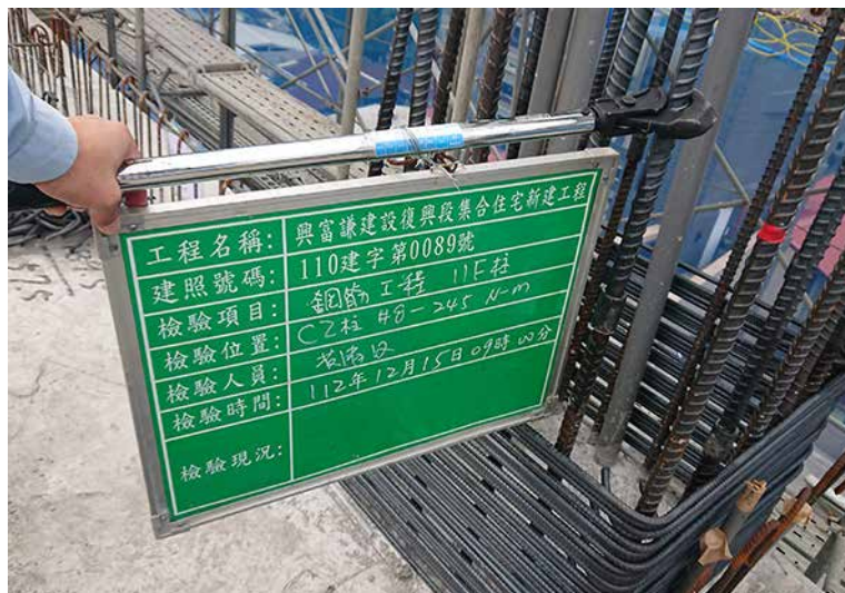
11柱筋續接扭力測試查驗
