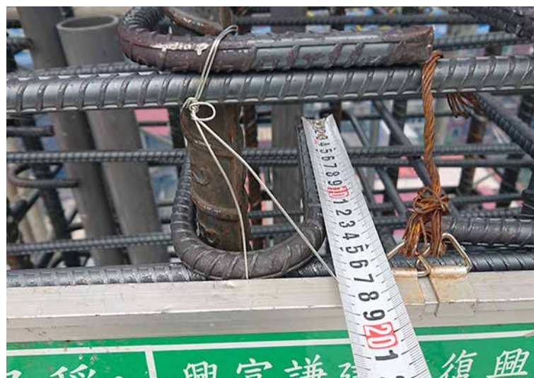
柱筋彎鉤查驗
