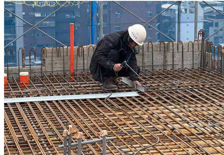
止水鋼板施作
