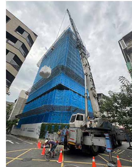
樑版鋼筋吊料
