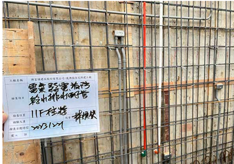
柱牆配管查驗
