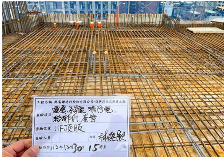
機電配管查驗
