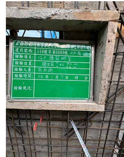
牆開口補強鋼筋
