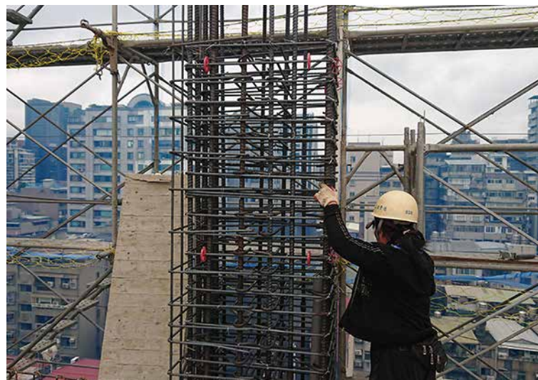
鋼筋柱筋綁紮
