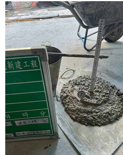
混凝土坍度檢測
