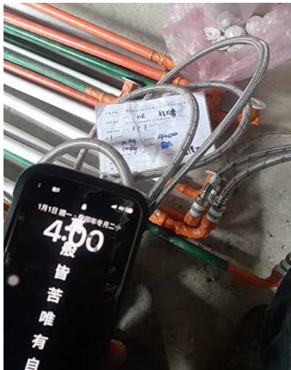
給水管配管前壓力測試
