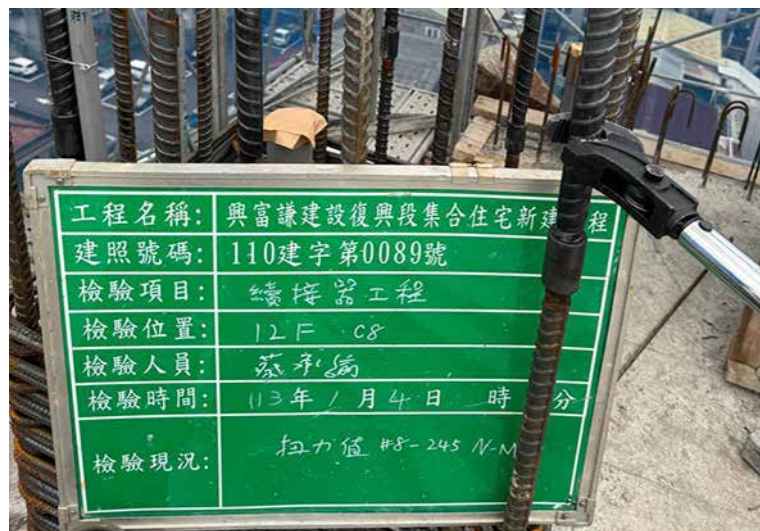
12F柱筋續接扭力測試查驗
