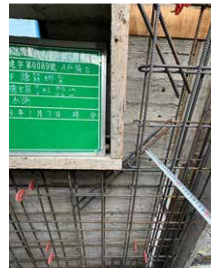
牆開口補強鋼筋
