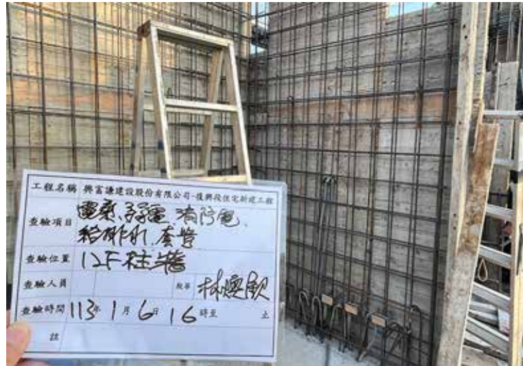
柱牆配管查驗
