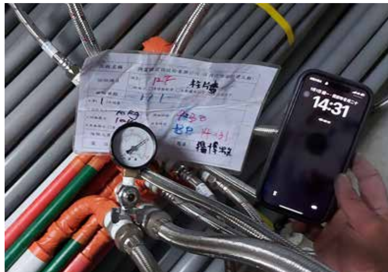
給水管配管前壓力測試
