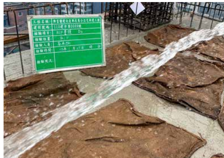
灌漿後鋪設麻布袋灑水養護
