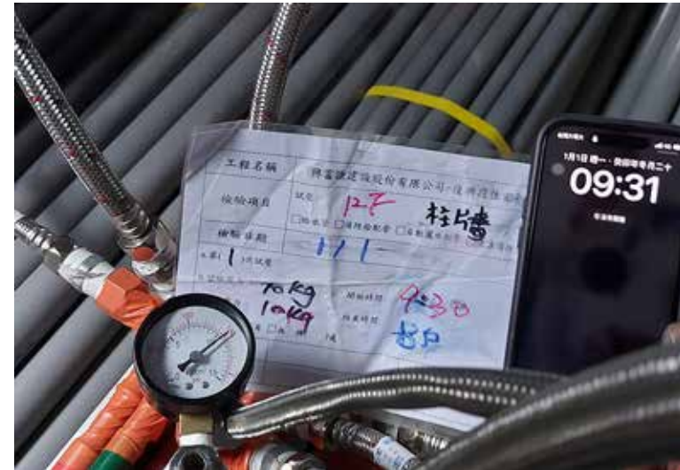
給水管配管前壓力測試
