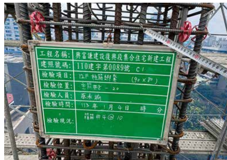
柱筋彎鉤查驗
