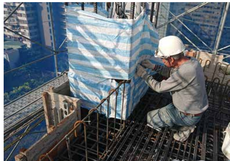
柱頭鋪設帆布保護，避免灌漿污染
