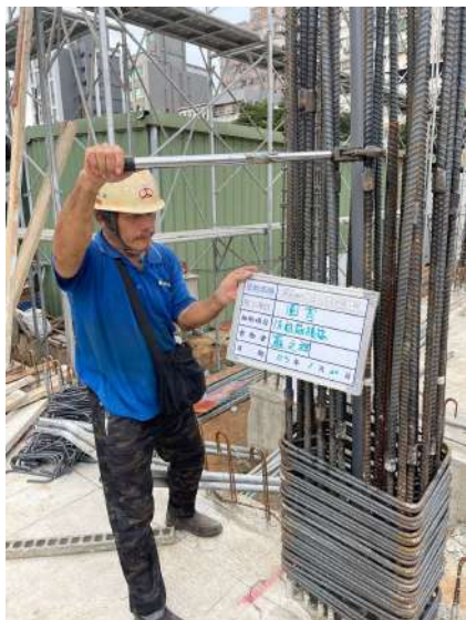
一樓柱筋扭力測試
