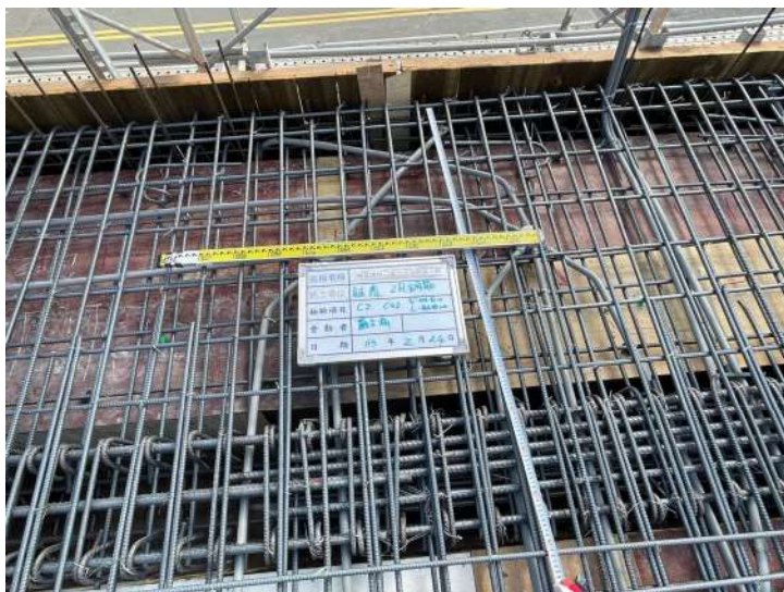
二樓版版鋼筋查驗
