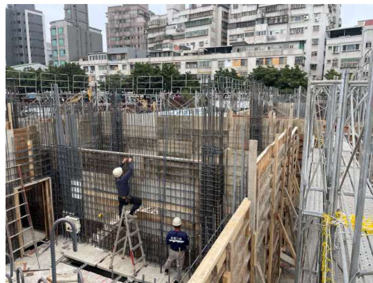
一樓牆筋綁紮
