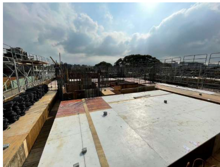
二樓版水電施工
