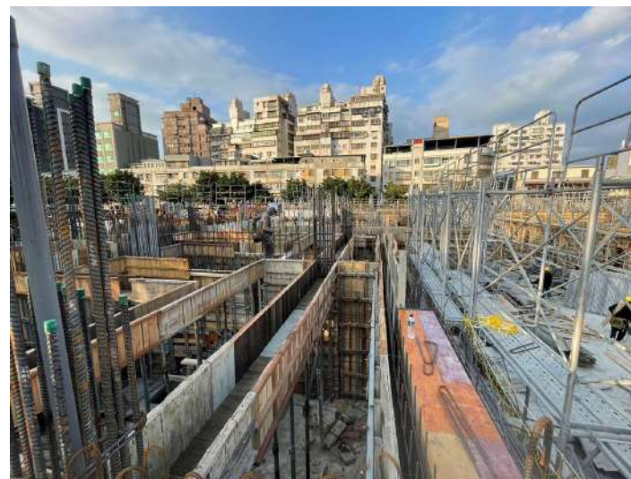
二樓版模板施工
