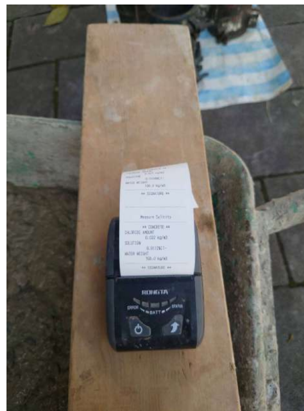
二樓版灌漿氯離子測試
