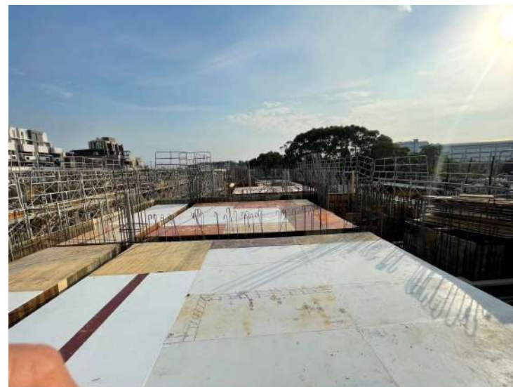
二樓版模板施工
