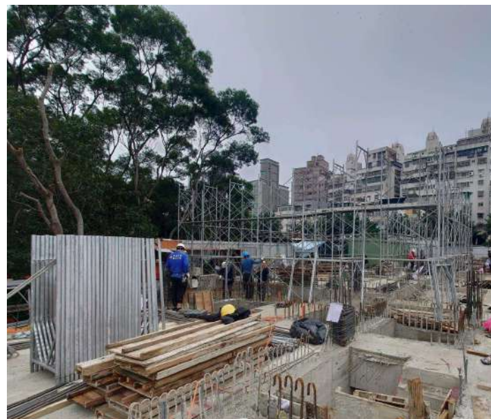
一樓施工架搭設
