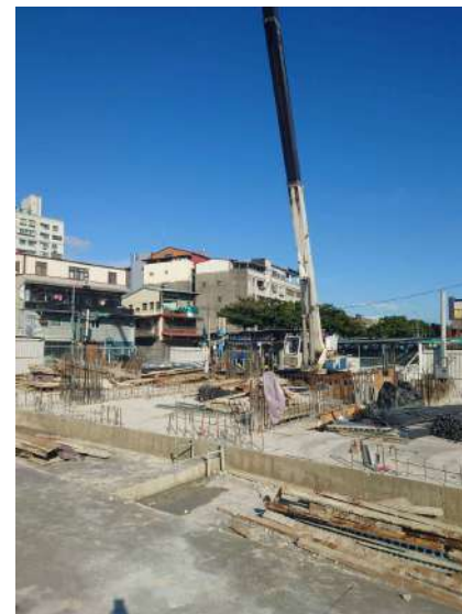
一樓柱牆鋼筋吊料
