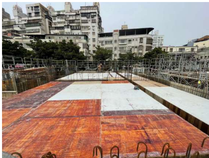
二樓版模板施工
