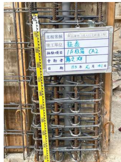
一樓柱筋查驗
