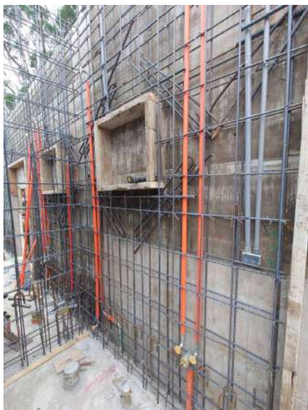
一樓牆水電配管
