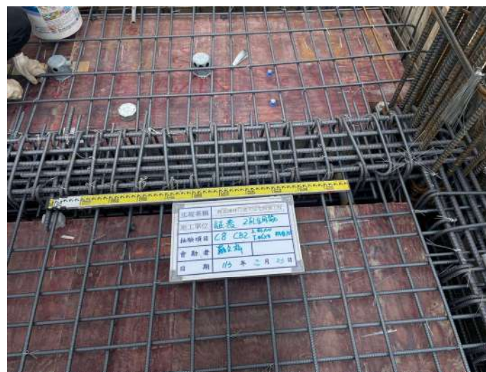
二樓版樑鋼筋查驗
