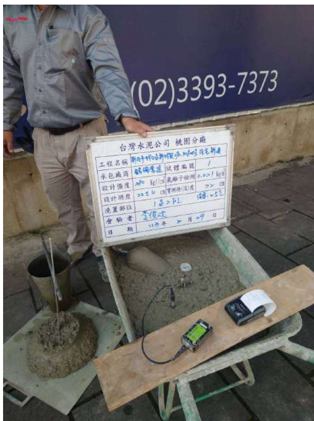
二樓版灌漿氯離子測試
