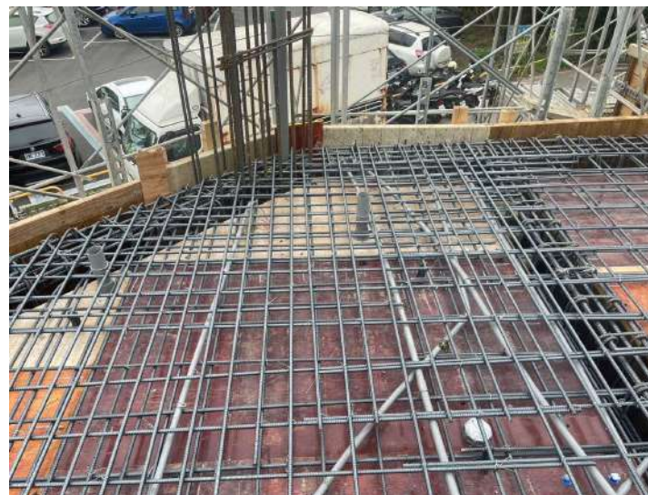
二樓版水電配管
