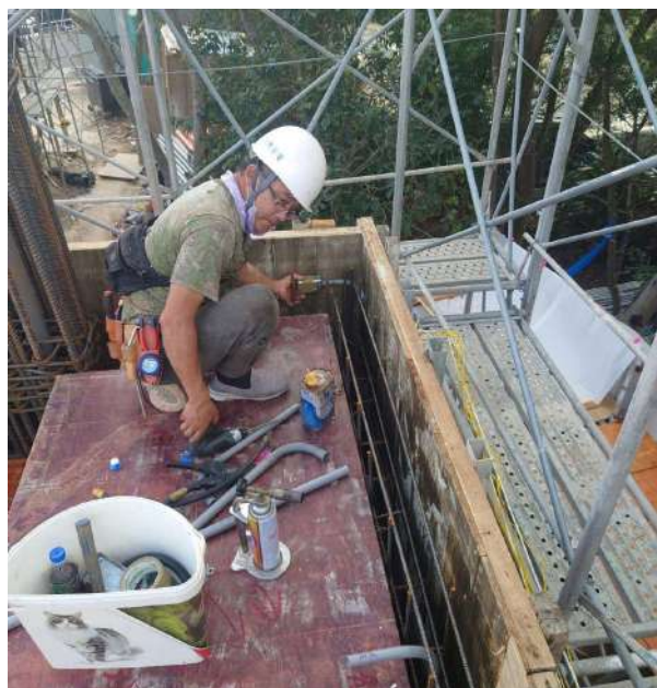
二樓版水電配管
