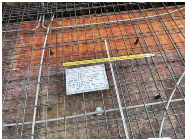
三樓版版鋼筋查驗
