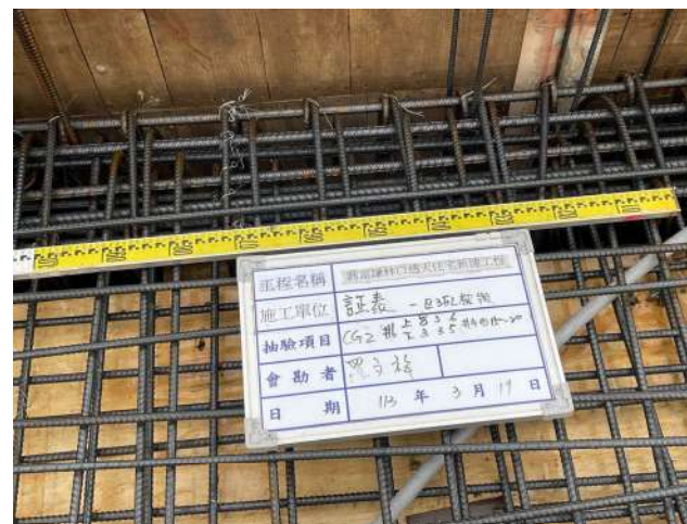
三樓版樑鋼筋查驗
