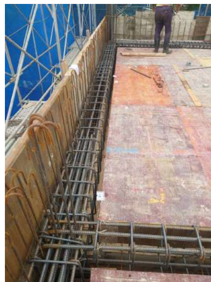
三樓版樑鋼筋綁紮
