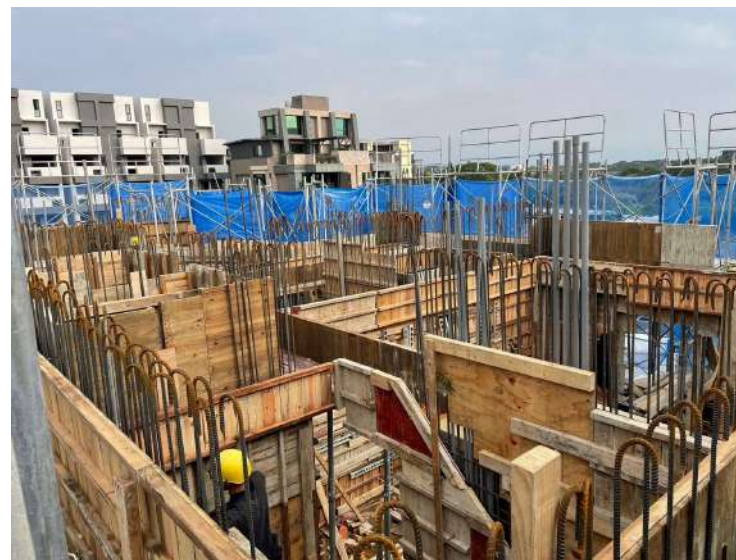
2F柱牆3FL樑版模板施工
