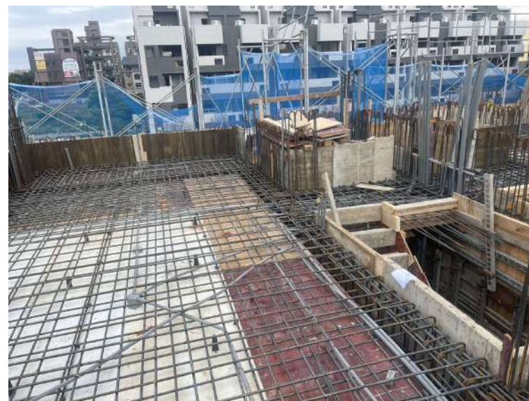
三樓版鋼筋綁紮
