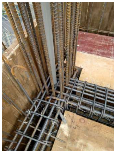
三樓版樑鋼筋綁紮
