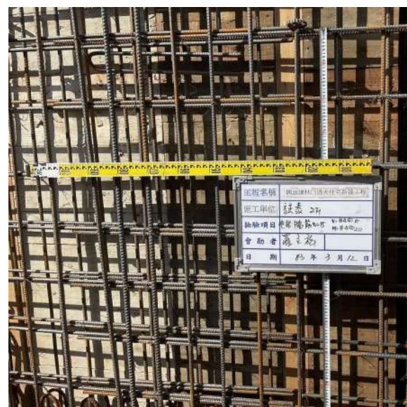
二樓牆施工查驗
