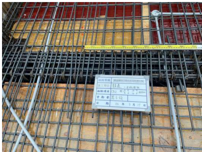
三樓版梁鋼筋查驗
