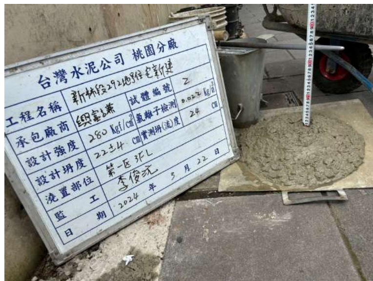
三樓版灌漿坍度測試
