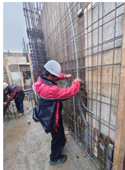
二樓水電配管
