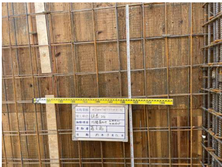
二樓牆筋施工查驗
