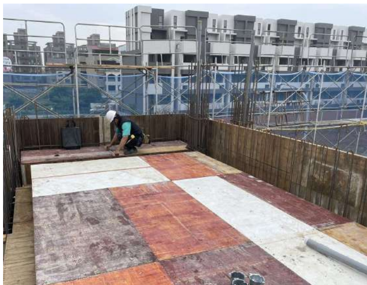
三樓版水電放樣施工
