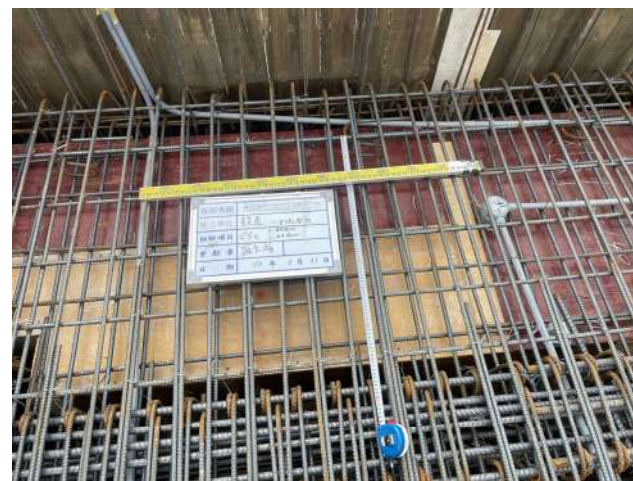
三樓版版鋼筋查驗
