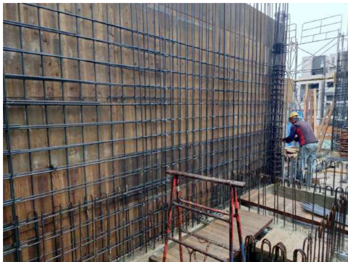
二樓牆筋綁紮
