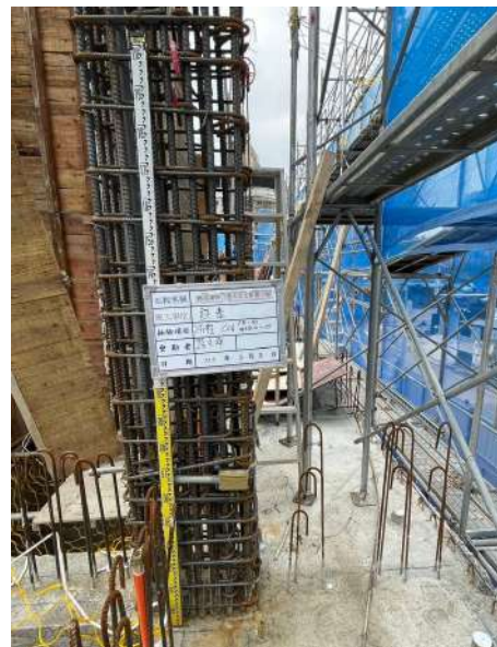
二樓柱筋查驗
