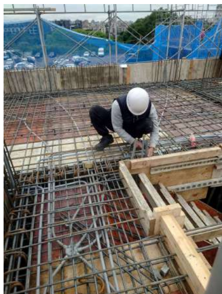
三樓版水電配管
