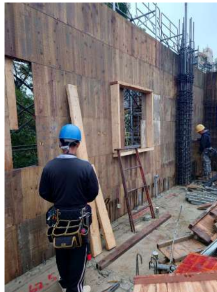
二樓模板施作
