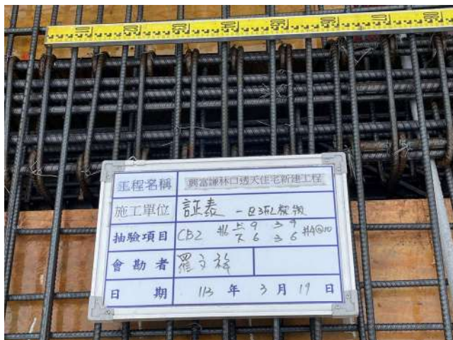
三樓版樑鋼筋查驗
