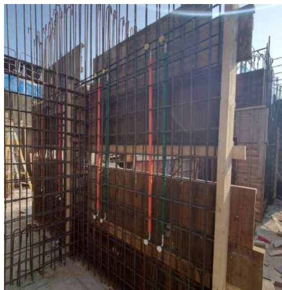
二樓水電配管
