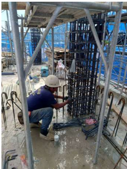
二樓柱筋綁紮
