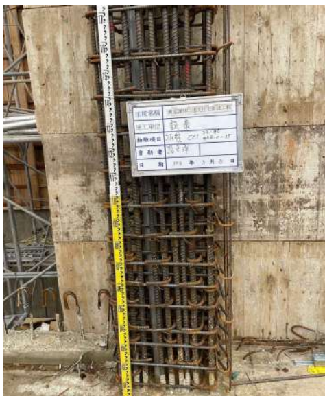
二樓柱筋查驗
