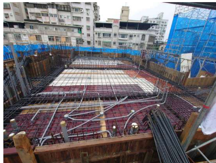
四樓版水電配管
