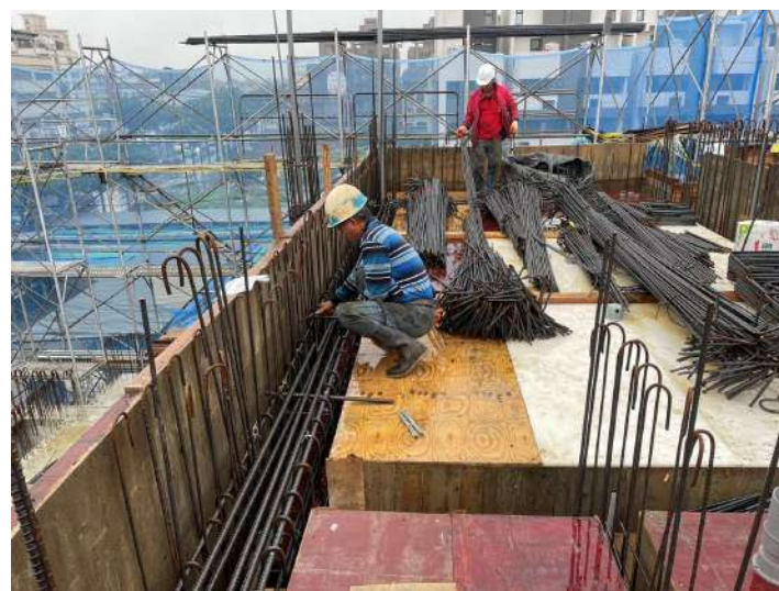
四樓版鋼筋綁紮
