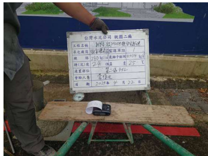
四樓版 混凝土氯離子檢測
