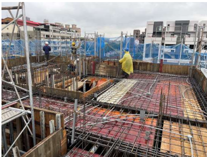
四樓版水電配管
