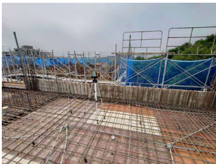
四樓版標高器施作
