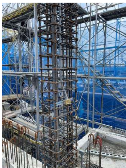
三樓水電配管
