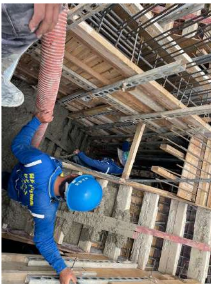
4FL混凝土澆置
