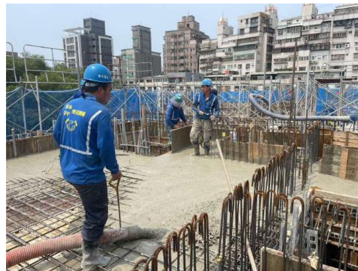
4FL混凝土澆置
