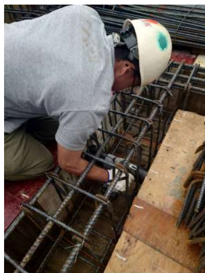
四樓版水電配管
