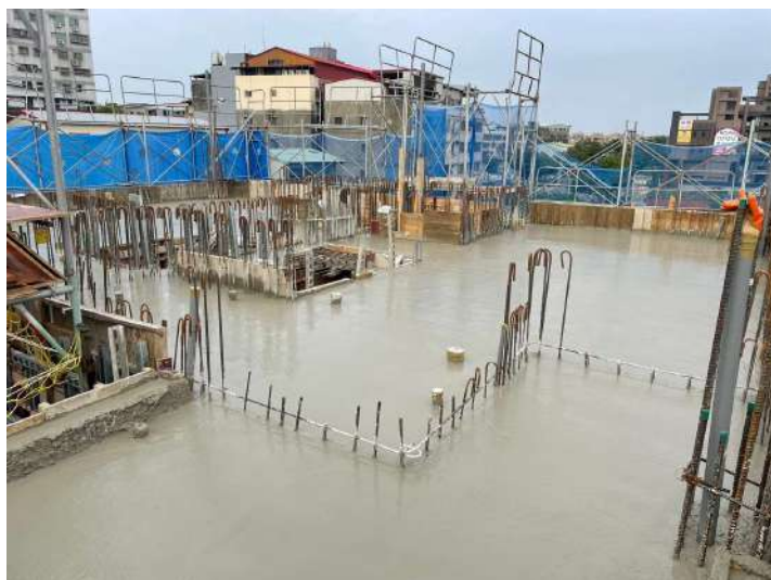
4FL混凝土澆置
