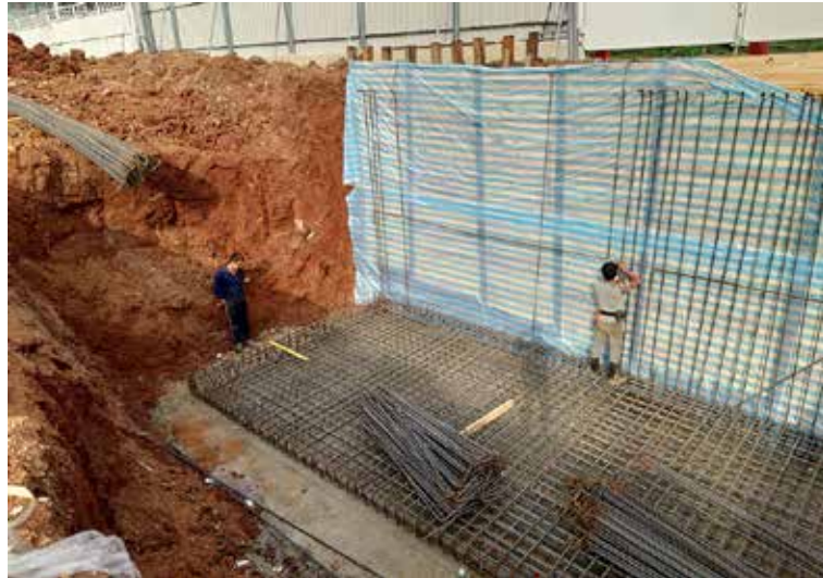
滯洪池鋼筋綁紮
