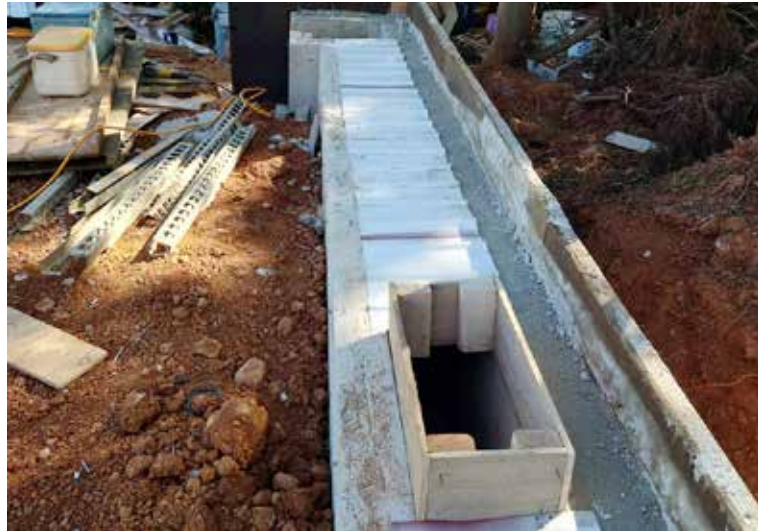
溝蓋板底模鋪設
