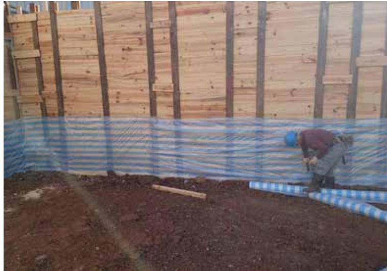
地下室鋼軌樁襯板及帆布鋪設
