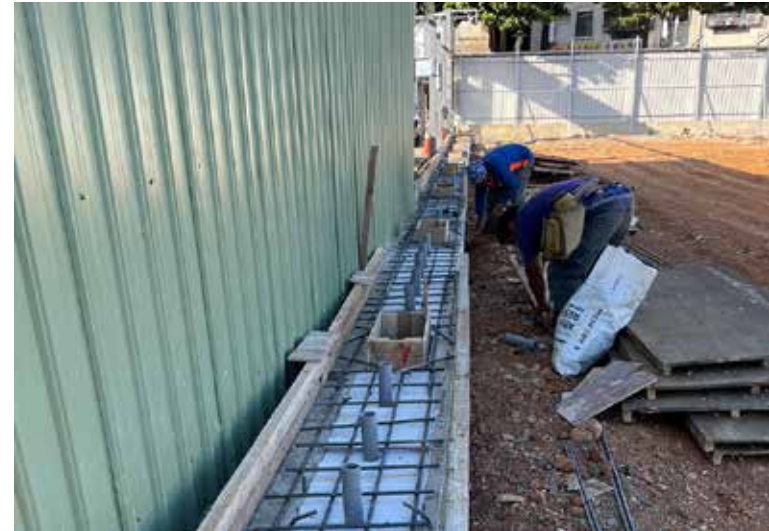
水溝蓋人孔及排水孔設置
