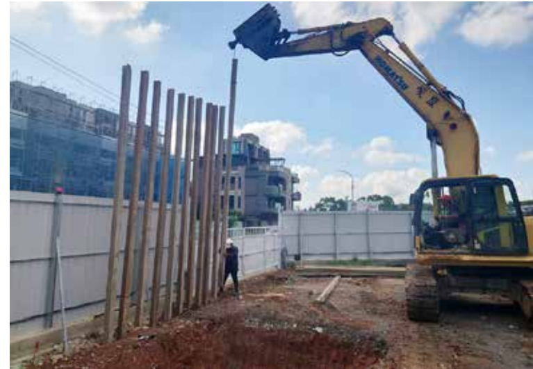
滯洪池鋼軌樁施作
