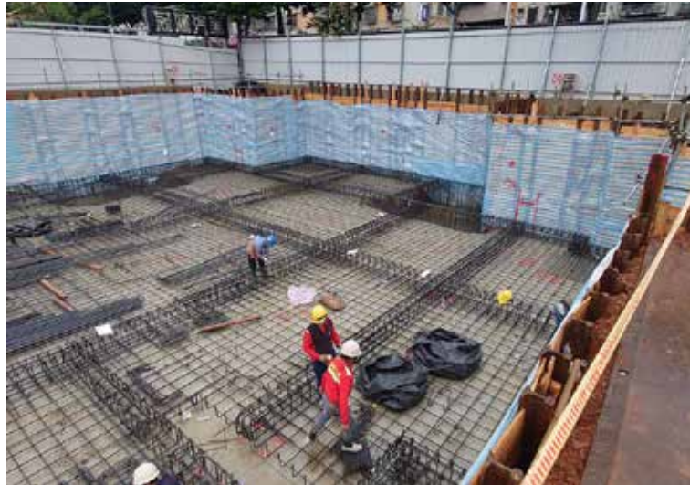
基礎樑版筋綁紮
