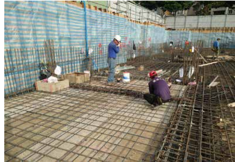
消防池版筋綁紮
