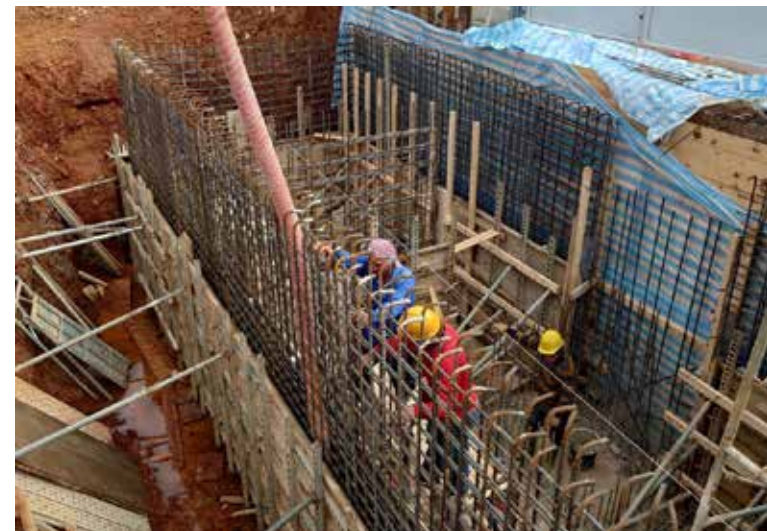
滯洪池半牆混凝土澆置
