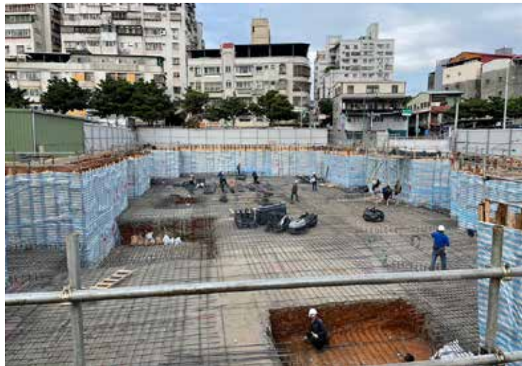
基礎版鋼筋綁紮
