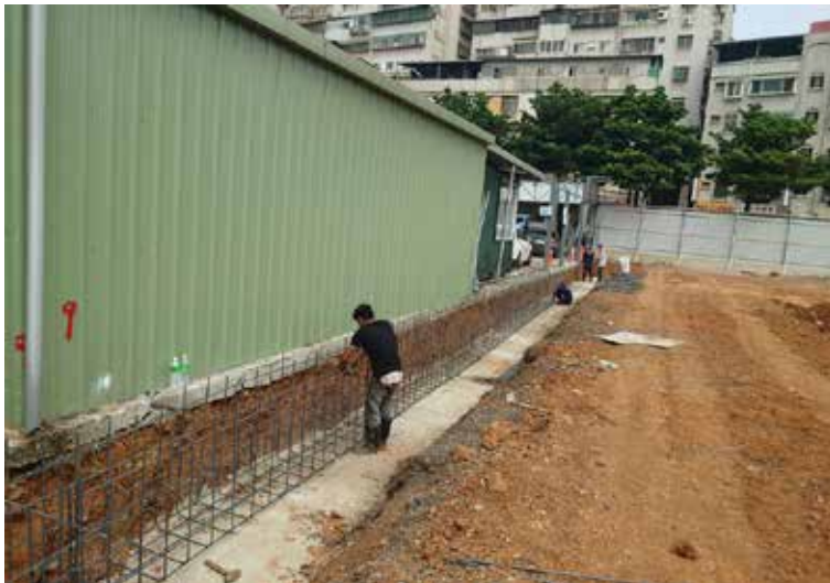
水溝鋼筋綁紮
