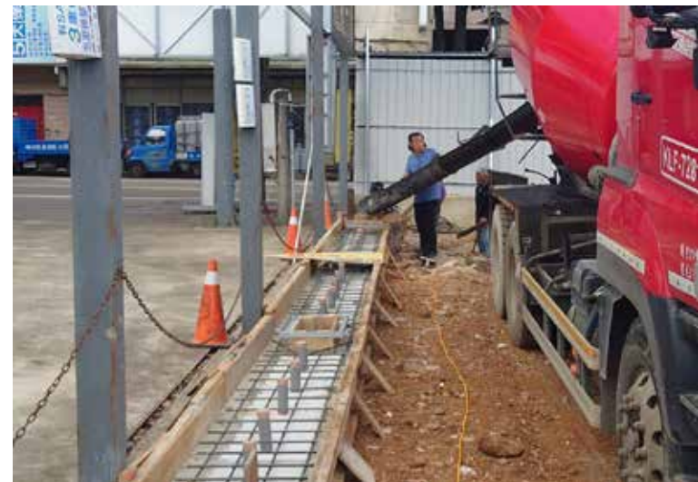
水溝蓋混凝土澆置
