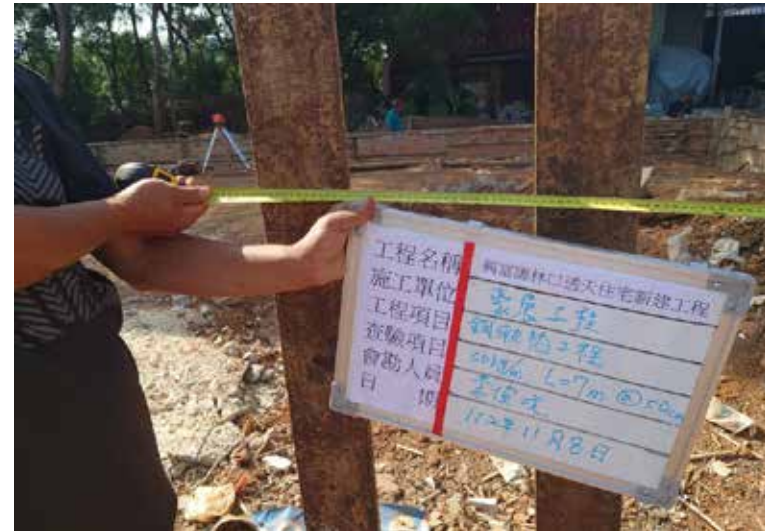
鋼軌樁打設間距查驗
