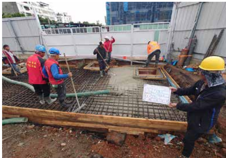
滯洪池頂版混凝土澆置
