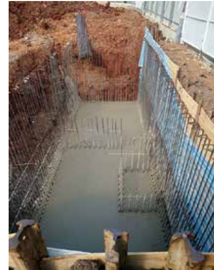
滯洪池底版混凝土澆置
