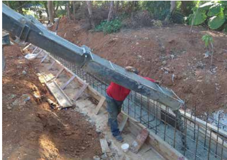
水溝底混凝土澆置
