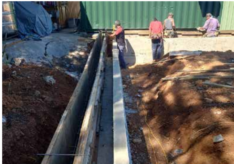
水溝牆拆模及立模
