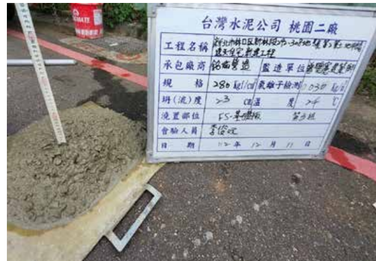
混凝土坍度檢測
