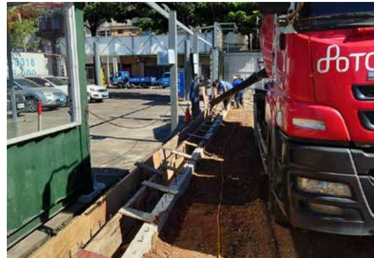
水溝第二面溝壁混凝土澆置
