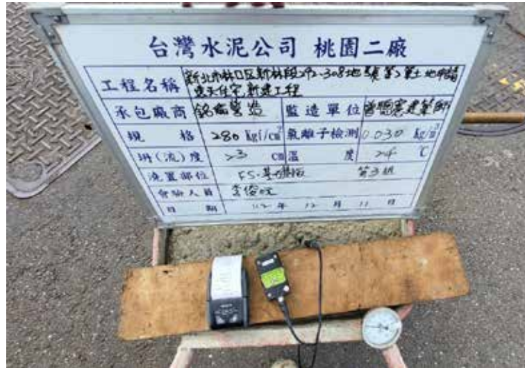
混凝土氯離子檢測
