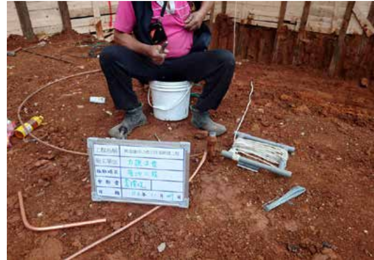
接地工程施工
