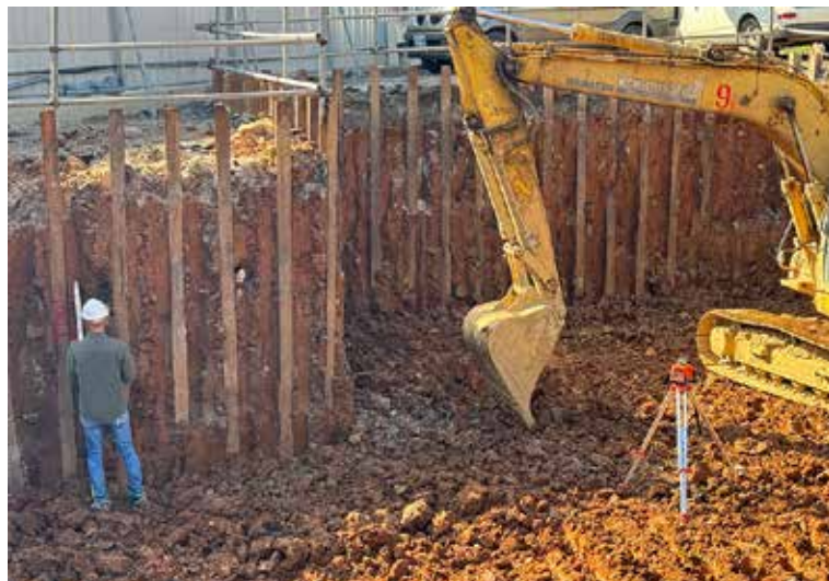
土方開挖及高程放樣
