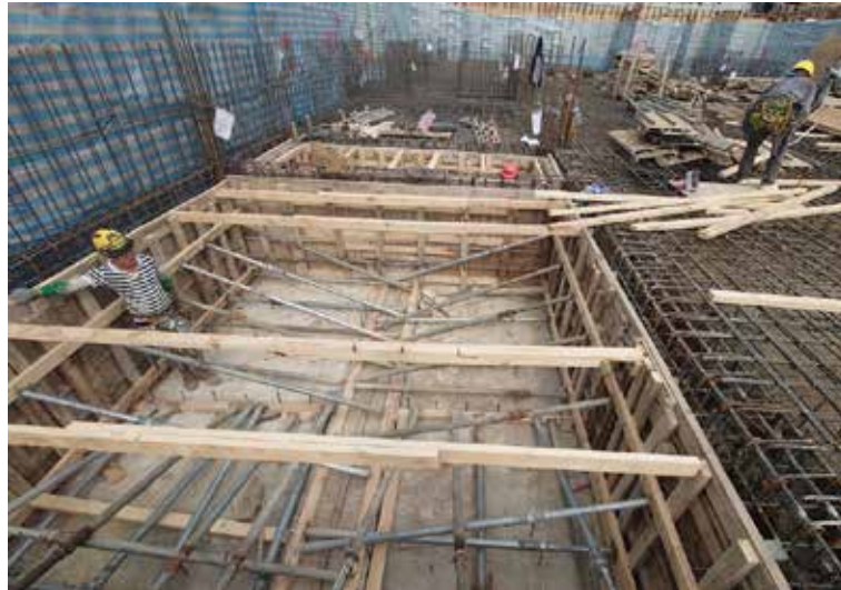
消防池模板組立
