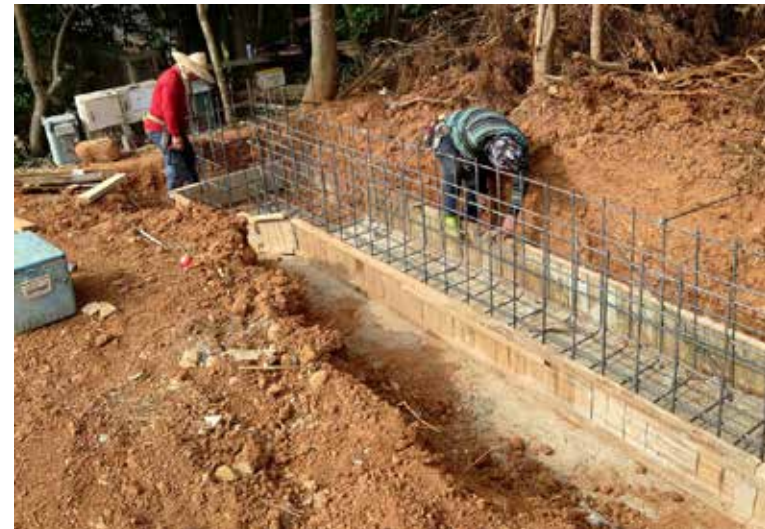
水溝模板構築
