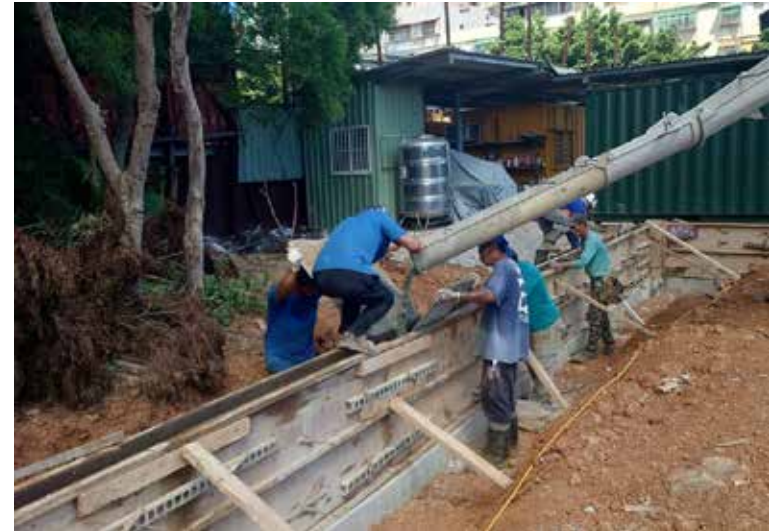
水溝牆單面模混凝土澆置
