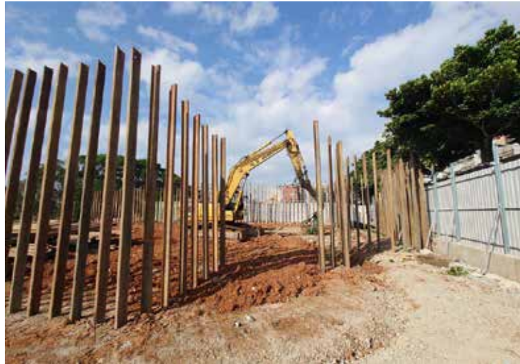
地下室範圍鋼軌樁施作
