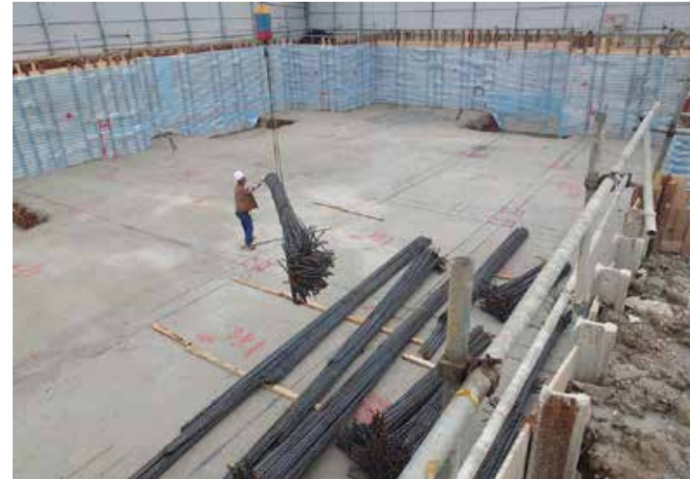
基礎版鋼筋吊置
