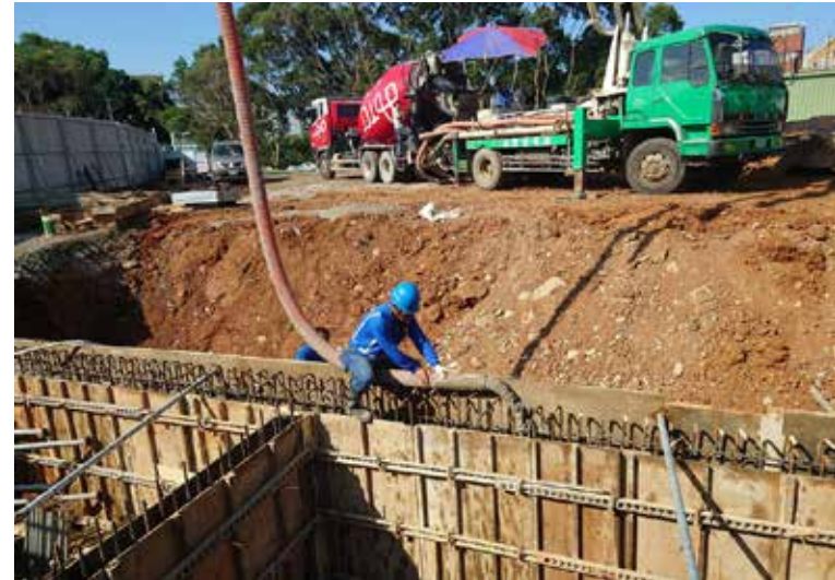
滯洪池上部半牆澆置
