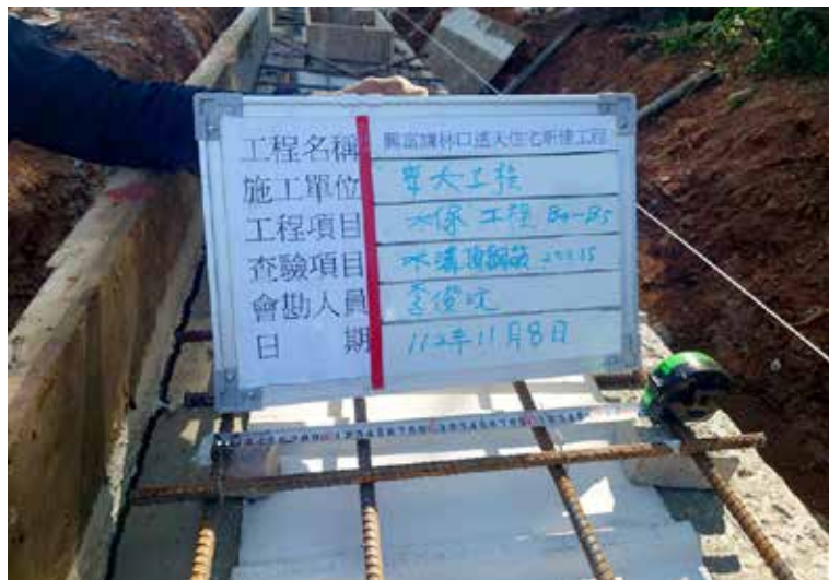
水溝鋼筋查驗
