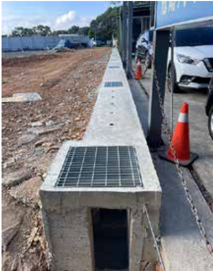
水溝澆置完成
