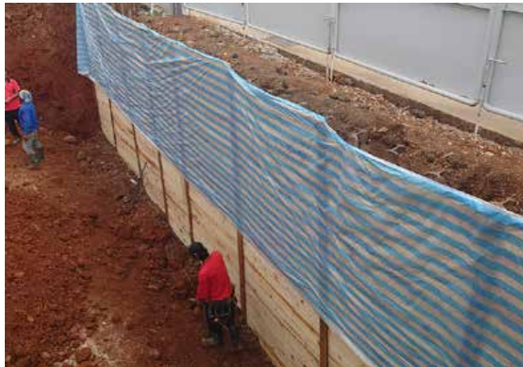
鋼軌樁襯板及帆布鋪設
