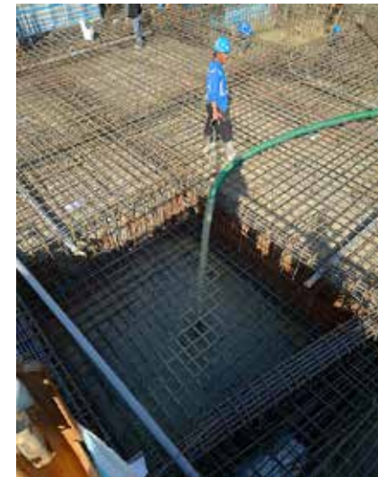
基坑混凝土澆置
