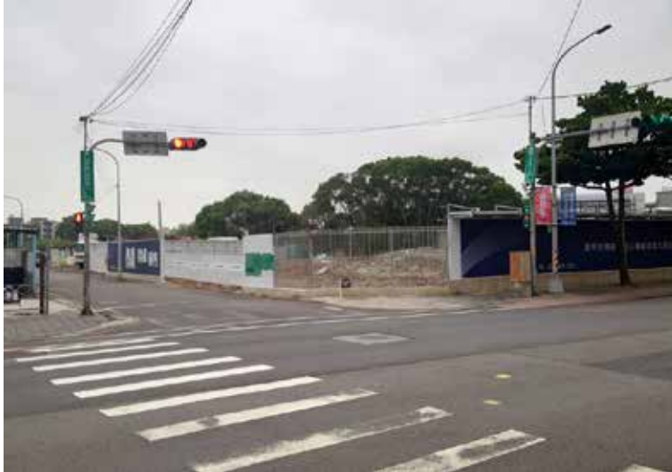
基地圍籬施作完成
