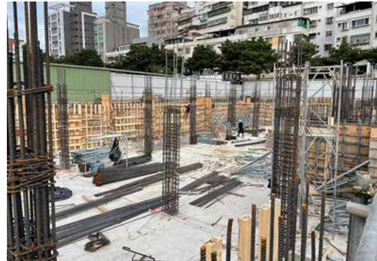
地下室半牆拆模
