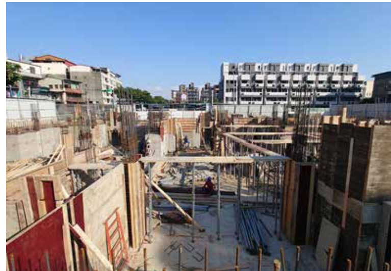
地下室模板施作
