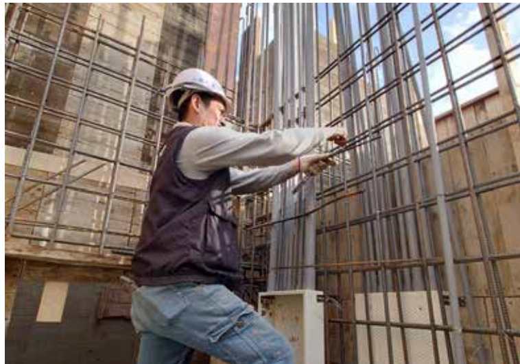
水電管鋼筋補強
