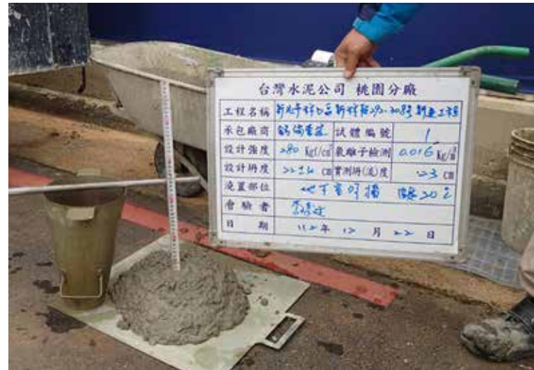
混凝土坍度檢測
