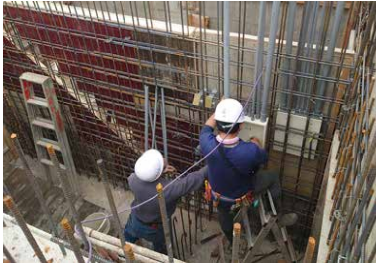
地下室水電配管
