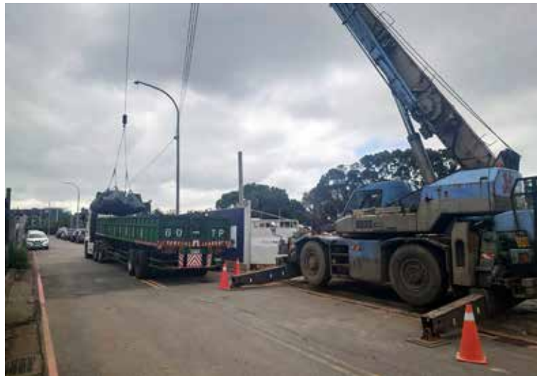
一樓版進鋼筋料
