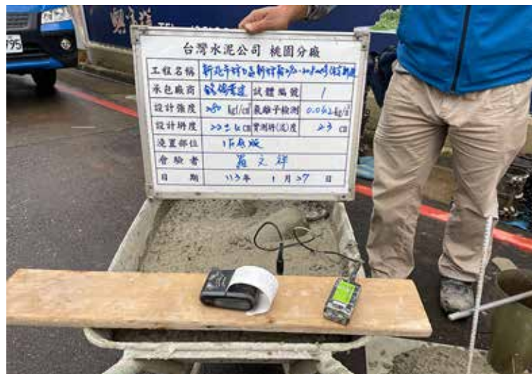
混凝土氯離子檢測
