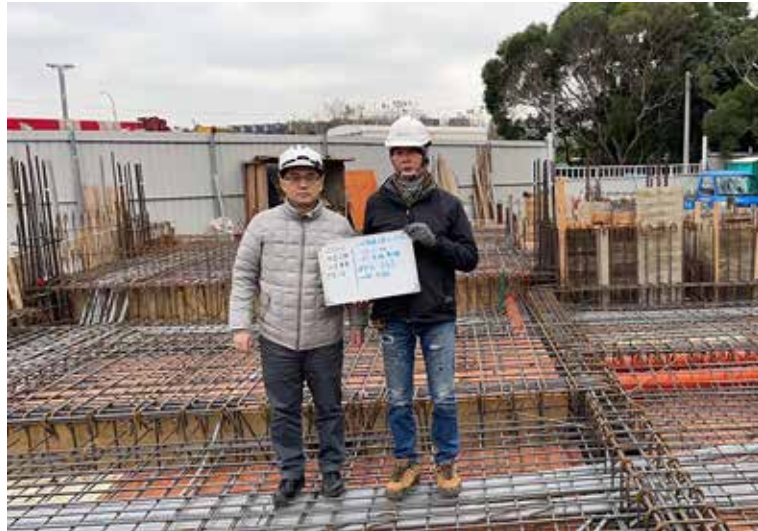
建築師一樓版勘驗
