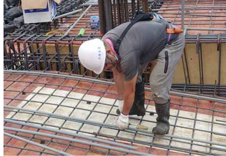
一樓版水電配管
