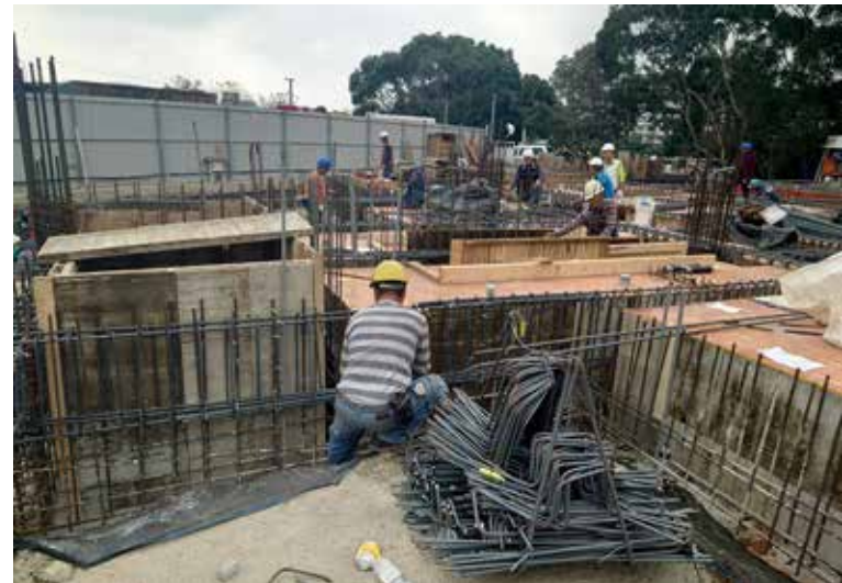
一樓樑筋綁紮
