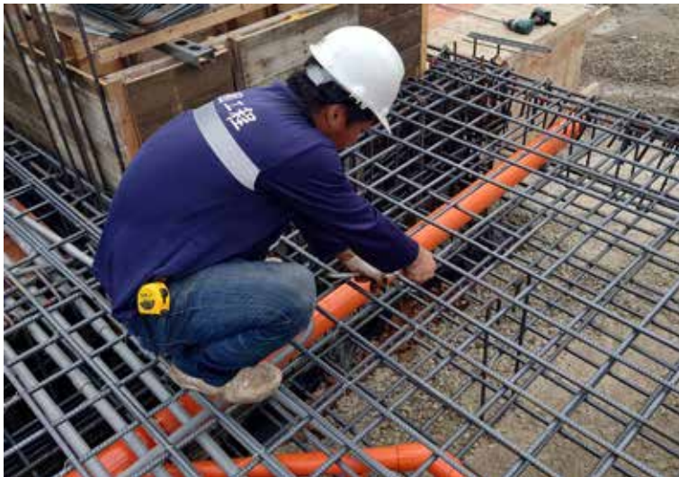
一樓版鋼筋綁紮
