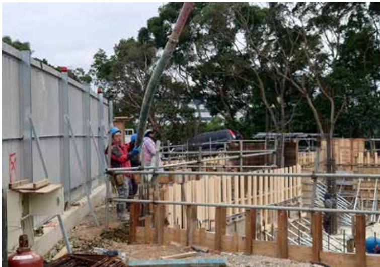
地下室半牆澆置
