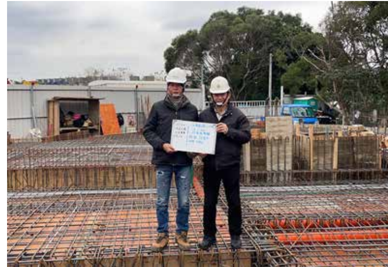
技師一樓版勘驗
