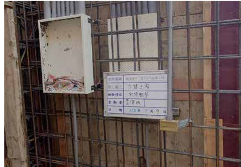
水電配管查驗
