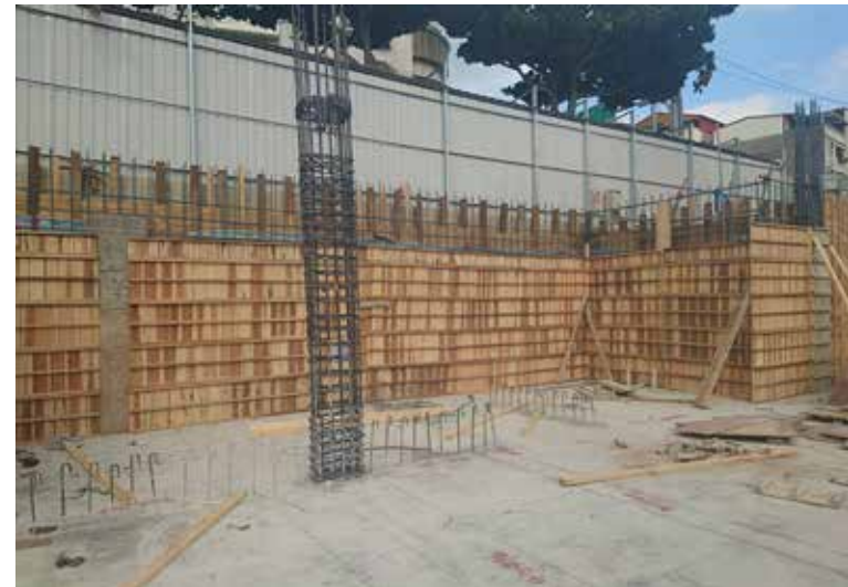
地下室模板施作
