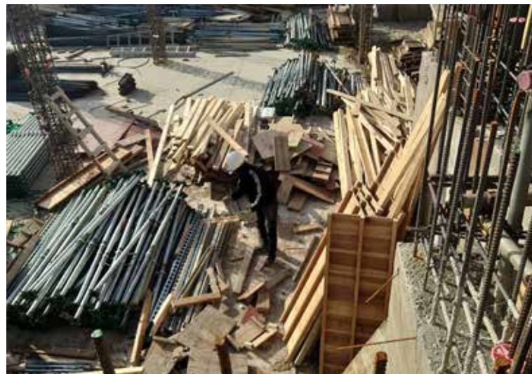
模板拔鐵釘及物料整理
