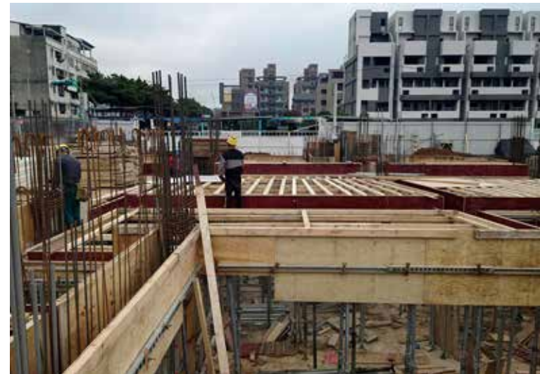
一樓版模施作
