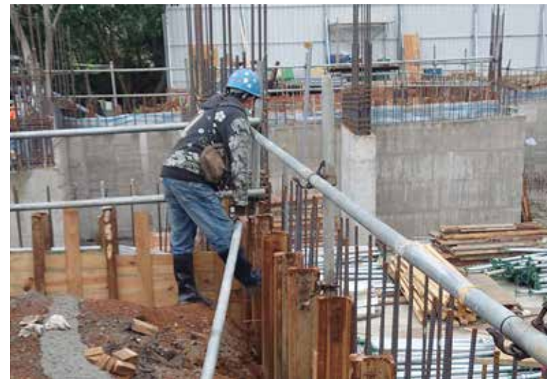
安全欄杆拆除
