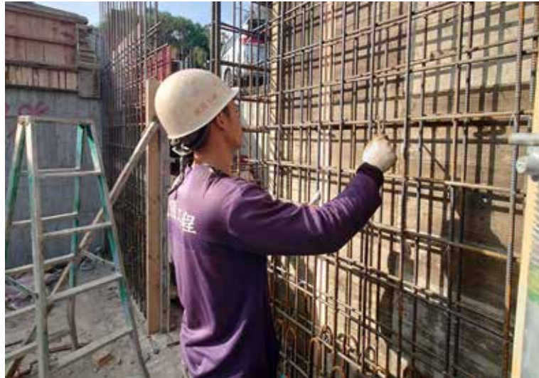
地下室牆筋綁紮
