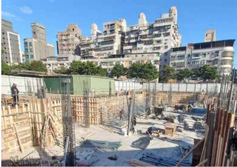
地下室牆模組立
